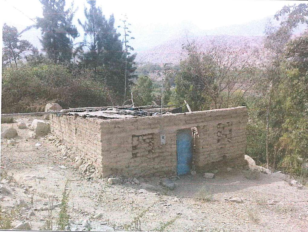
Se observa vivienda con muros de adobe con cobertura de calamina y quincha con torta de barro en mal estado de conservación, que podría colapsar como consecuencia de lluvias intensas, sismo u otra fuerza.
