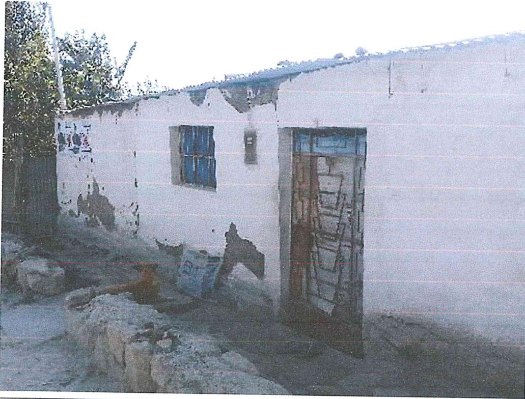
Vivienda con muros de adobe con cobertura de techo de calamina, se observa fisuras y agrietamientos en la fachada de la edificación.
