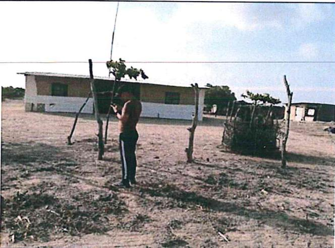
Foto N° 15: Vivienda de adobe y techo de calamina, revestido con plástico sus paredes, para evitar que se humedezca por las lluvias.
