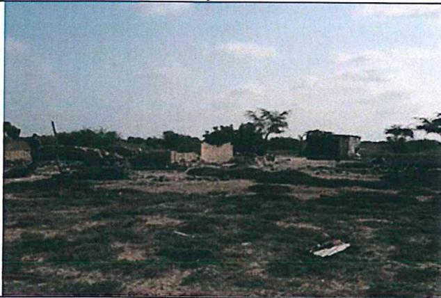
Foto N° 09: Viviendas de adobe, inhabilitada por el colapso de sus paredes y techo.
