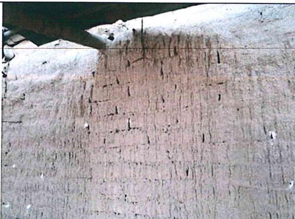
Foto N° 21: Vivienda de adobe, se observa pared erosionada por las filtraciones de las lluvias, a punto de colapsar.
