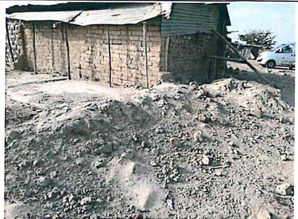
Foto N° 18: Vivienda de adobe, a punto de colapsar una de sus paredes.
