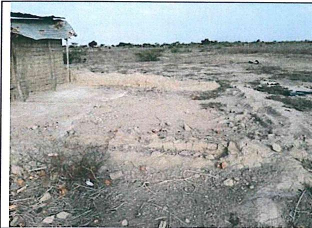
Foto N° 17: Vivienda de adobe, se observa la base de la pared que ha colapsado.
