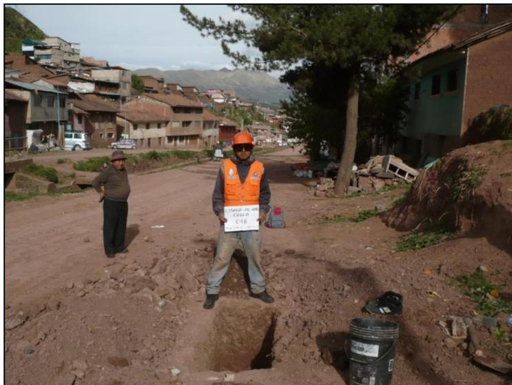
**Figura 7.1.** Excavación de calicata en el distrito del Cusco
