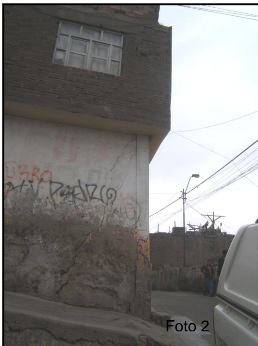
Foto 2 y 3.- Manzana "O" se aprecia las paredes de las viviendas agrietadas.
