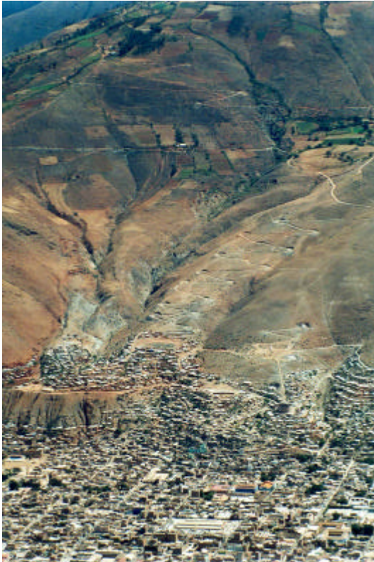
Foto N° 6 Vista panorámica de la quebrada Jactay, donde se distinguen los procesos de cárcavas y deslizamientos activos, así como la ocupación del suelo. Se distingue en la parte inferior de la foto el sector de Pampa Blanca, remanente de una terraza aluvial antigua disectada.
