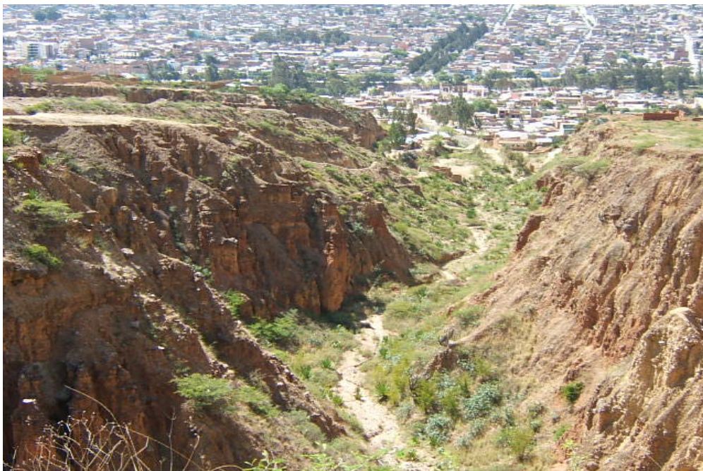
Foto N° 31 Vista de la quebrada Llicua aguas abajo, donde se aprecia el cauce principal angosto de la quebrada que corta depósitos de huayco antiguos; hacia el fondo parte del abanico.
