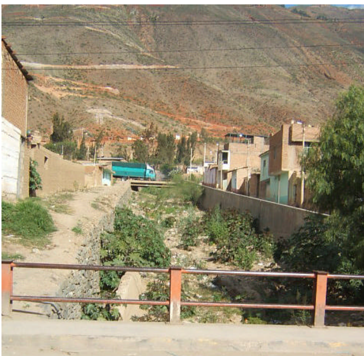
Foto N° 32 Vista aguas arriba de la quebrada Llicua desde la carretera a Tingo María, la cual se ha encauzado en su tramo final.
