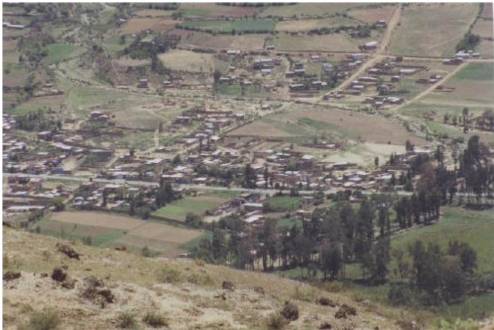
Foto N° 34 Vista aguas arriba del sector de La Esperanza donde se distingue la curva en el cauce de la quebrada que produjo un huayco reciente.
