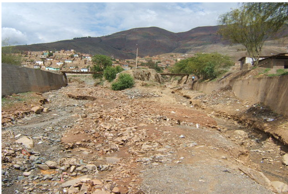
Foto N° 9 Vista de la confluencia de las quebradas Tingoragra y La Florida, aguas arriba de la avenida Huallayco. Se distingue el material reciente de los últimos huaycos.
