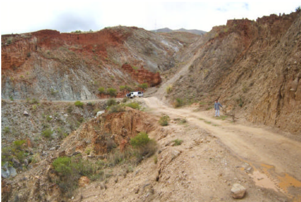
Foto N° 12 Deslizamiento que afecta tramo de la trocha hacia Rondos y Nauyán. Nótese el cabalgamiento y agrietamiento en la carretera y los asentamientos en ambas márgenes (cárcava izquierda quebrada Tingoragra-Rondos).
