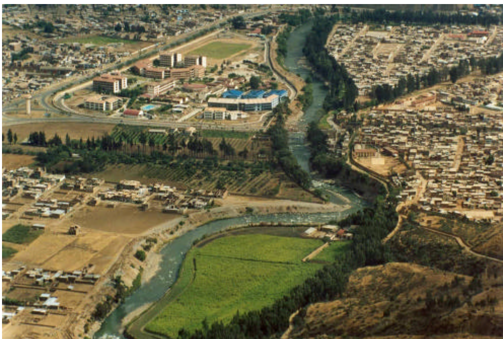
Foto N° 36 Vista aguas abajo del río Huallaga en el sector de la Universidad de Huánuco, cauce divagante encajonado, susceptible a inundaciones excepcionales y erosión fluvial.
