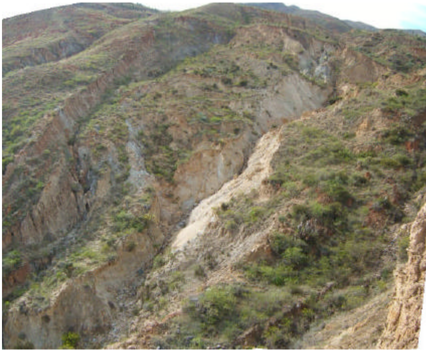
Foto N° 16 Vista aguas arriba en la cárcava central de la quebrada Tingoragra-Rondos que muestra una zona de deslizamiento complejo con movimientos longitudinales y transversales al cárcavamiento.
