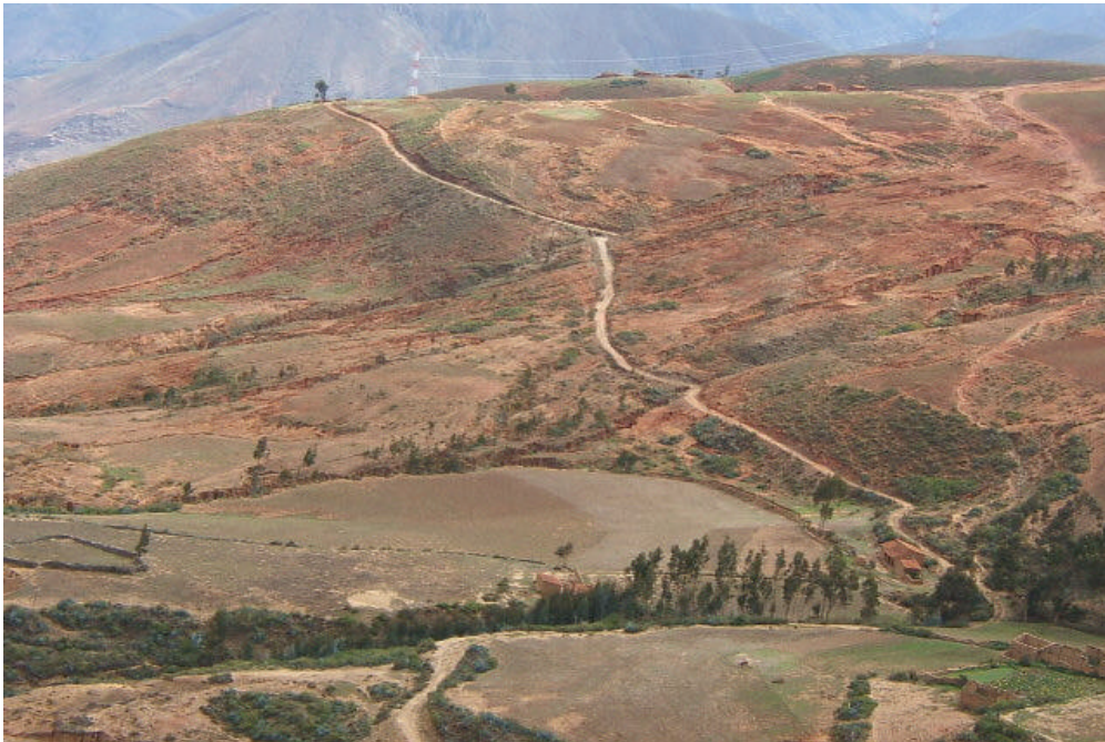
Foto N° 18 Vista hacia el suroeste sobre la trocha carrozable entre Rondos y Nauyán. Nótese el proceso de erosión en surcos y cárcavas sobre las laderas de suelo residual.
