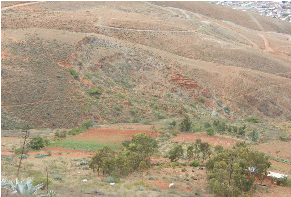
Foto N° 7 Vista hacia el norte que muestra una zona de deslizamiento activo en la margen izquierda de la quebrada Jactay. Nótese el tipo de suelo residual aprovechado por áreas de pastos y cultivos.
