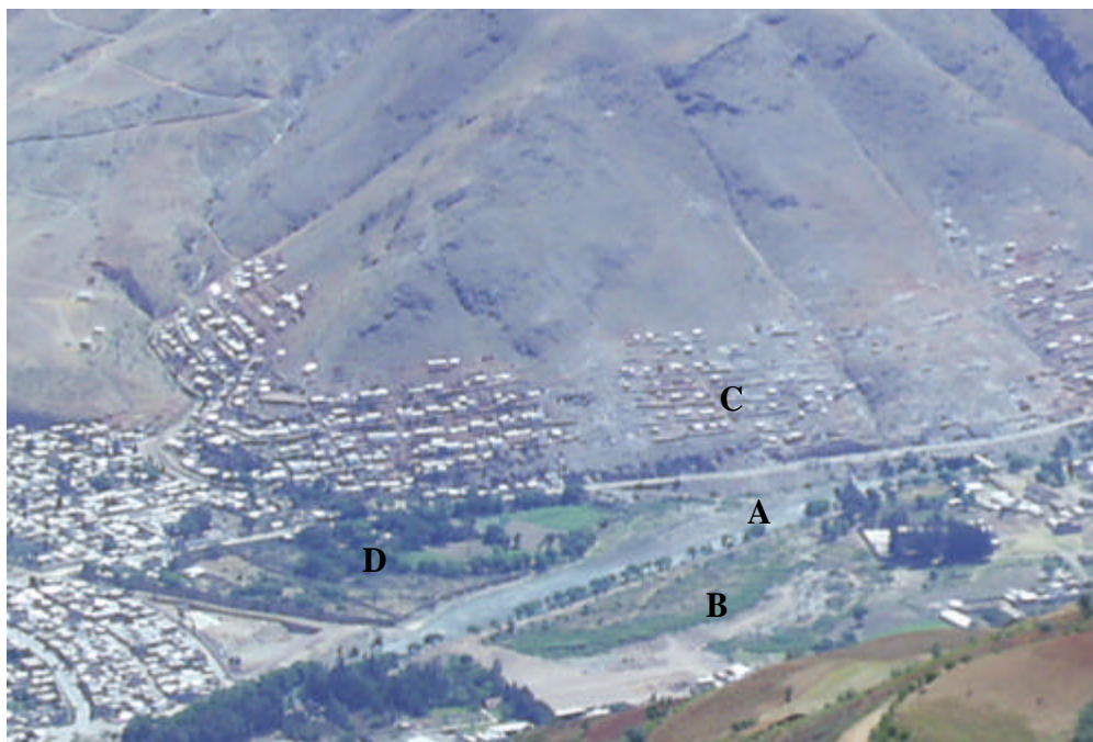
Foto N°3 Sector de Huayupampa, con acumulación de depósitos fluviales (A), aluviales de terraza baja inundable (B), depósitos de vertiente coluviales al pie de laderas ocupadas por asentamientos humanos (C) y proluviales en la desembocadura (D).
