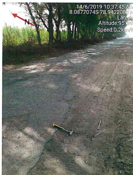
**Figura 23.** Vista de 200 m de tramo de carretera Laredo-Galindo y áreas de cultivo afectado por los flujos de detritos de la quebrada San Carlos, activados por caudales anómalos debido a precipitaciones del evento Niño Costero 217. Fuente: Elaboración propia 2019
