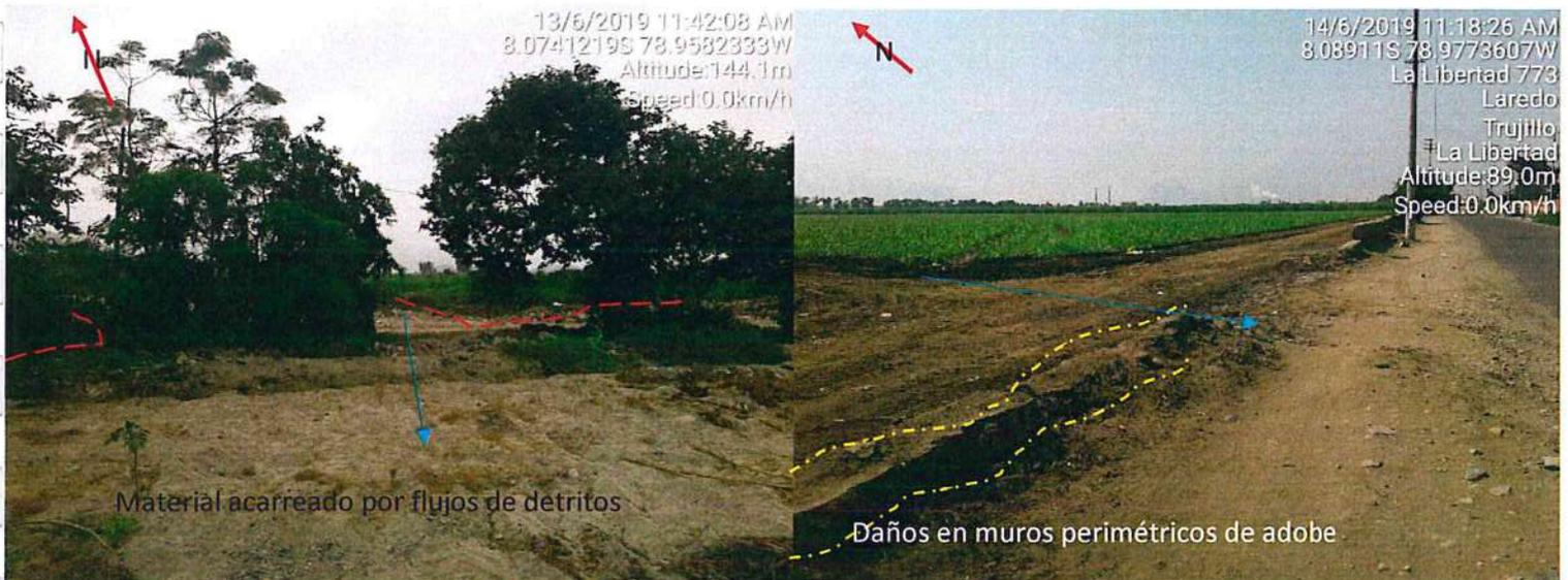
**Figura 25.** Quebrada Las Uvas o San Idelfonso de Laredo, se aprecia material dejado por los flujos de detritos que afectó el cerco perimétrico de adobe, la vía asfaltada “El Porvenir-Laredo” y áreas de cultivo (Caña y verduras). Fuente: Elaboración propia 2019
