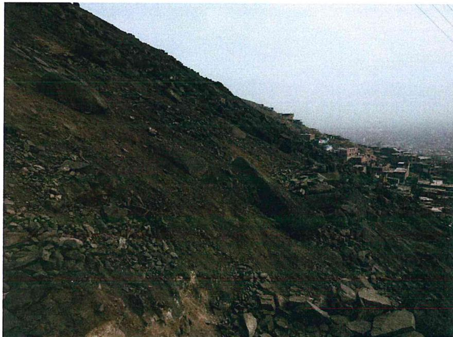
Fotografía 14. Zona 7, derrumbes y desprendimientos de rocas de hasta 1 m de diámetro en la parte alta del AA.HH. Vista Alegre al SE del cerro El Agustino.
