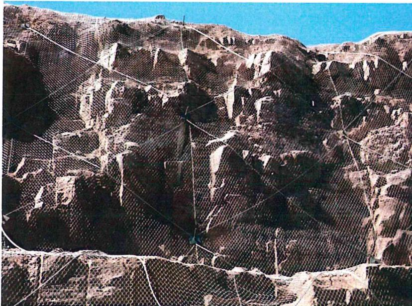
Figura 20. Control de caída de rocas utilizando mallas ancladas
