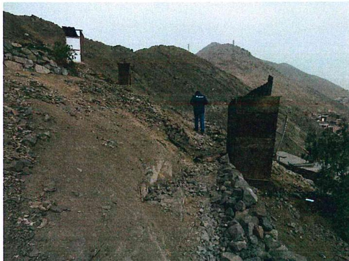
Fotografía 12. Zona 6, derrumbes y desprendimiento de detritos en la parte alta del AA.HH. Hijos de Perales y Las Terrazas de Perales, la presencia de los silos humedece el terreno, aumentando la inestabilidad de estas laderas.
