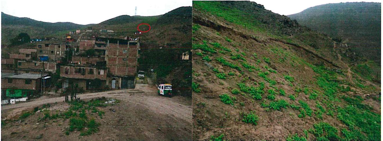
Figura 12. Depósitos de arena con espesores entre 60 a 80 cm, de grano medio, en el flanco sureste del cerro El Agustino, en la parte alta de la manzana H5 de la Cooperativa de Vivienda Virgen de Las Nieves. Al extraer material en la base se generan derrumbes en la zona 3.
