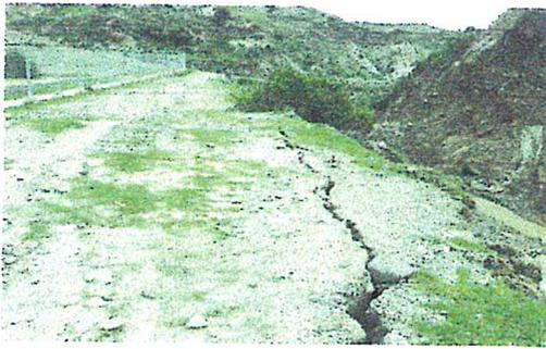
Vista Actual de como se estan partiendo los terrenos y se estan desmoronando producto de la erosion y socavamiento producido por las constantes y persistentes lluvias que estan a punto de hacer colapsar las estructuras de las lagunas de oxidacion que practicamente ya estan a punto de ser arrasados por los huaycos - requieren pronta intervencion y asegurado con muros de contencion (margen derecha laguba rio qanqoyaku
