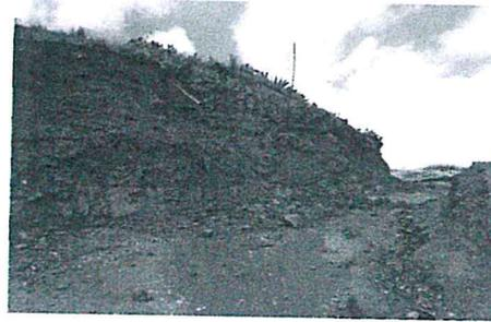
Vista actual del camino de acceso a las lagunas de oxidacion que estan con derrumbes, a consecuencia de las constates y persistentes lluvias, requiere pronta intervencion, ya que estos materiales de lodo y piedra que se desprenden van directamente alas lagunas de oxidacion por la parte alta (cabecera de laguna)
