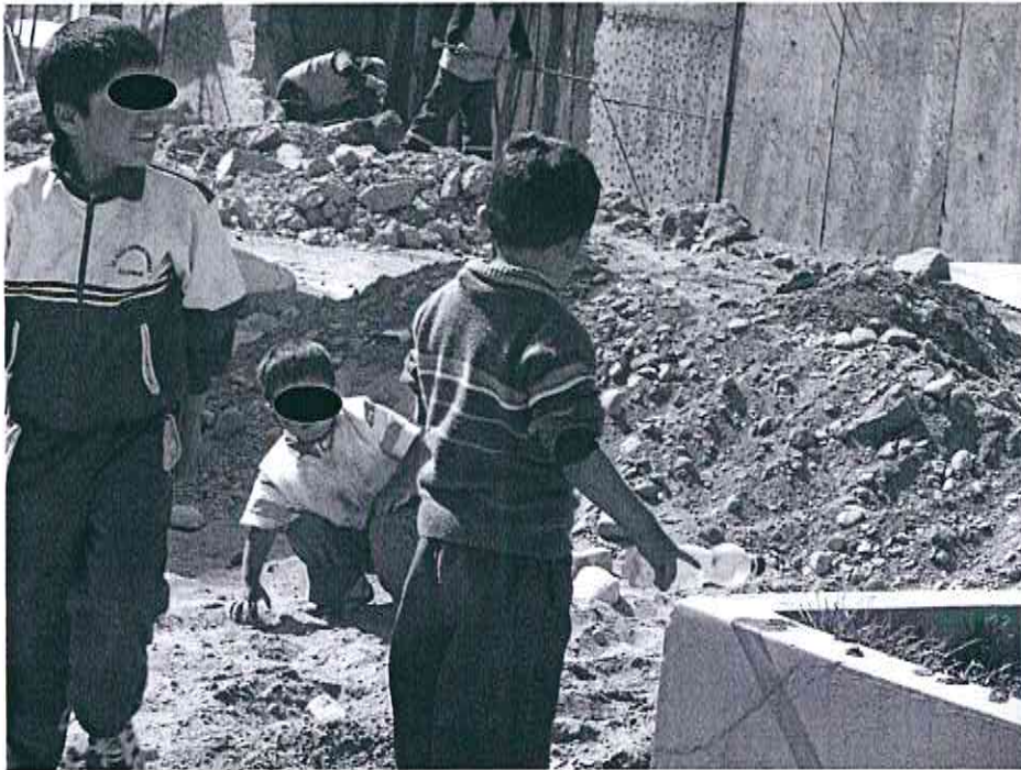
Foto 19: Se observa a niños jugando sin protección alguna en el poblado de Lloque, totalmente expuestos a las partículas provenientes del Volcán San Pedro y de la obra en ejecución en el Distrito de Lloque, vista tomada el 26 de mayo del 2014.
