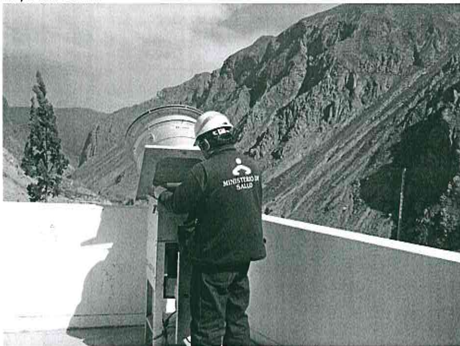
Foto 18: Instalación del filtro en el muestreador de alto volumen para PM10 (DIRESA) en el hotel de Lloque ubicado en el centro poblado de Lloque, vista tomada el 26 de mayo del 2014.
