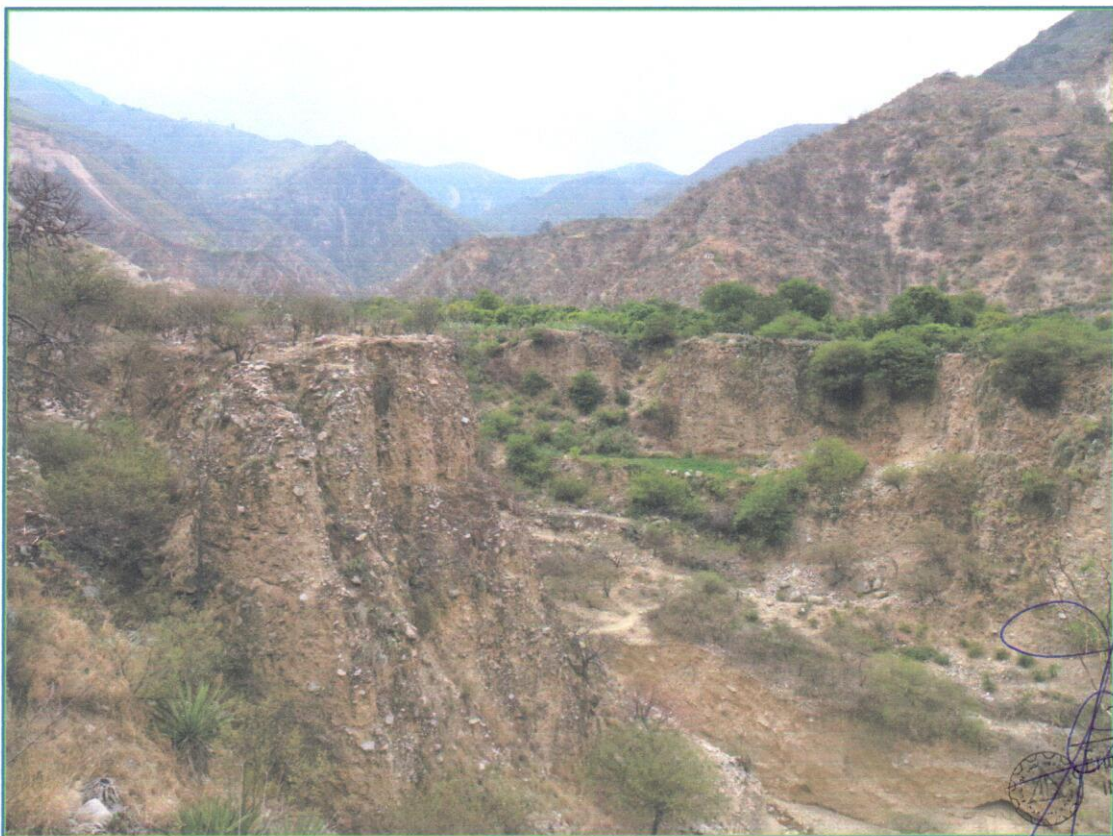
FOTOGRAFIA N° 02: Vista panorámica, de las zonas erosionadas por el deslizamiento de taludes y las avenidas pasadas.
