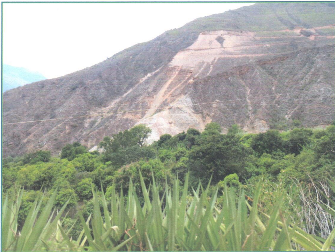
FOTOGRAFIA N° 05: Vista panorámica, valle del río Chuyama, áreas agrícolas, viveros, frutales en riesgo inminente ante un desborde taludes inestables.
