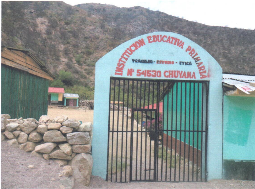
FOTOGRAFIA N° 07: Vista panorámica, de la institución educativa nivel Primaria, material adobe, madera y cerco perimétrico de piedras provisionales.
