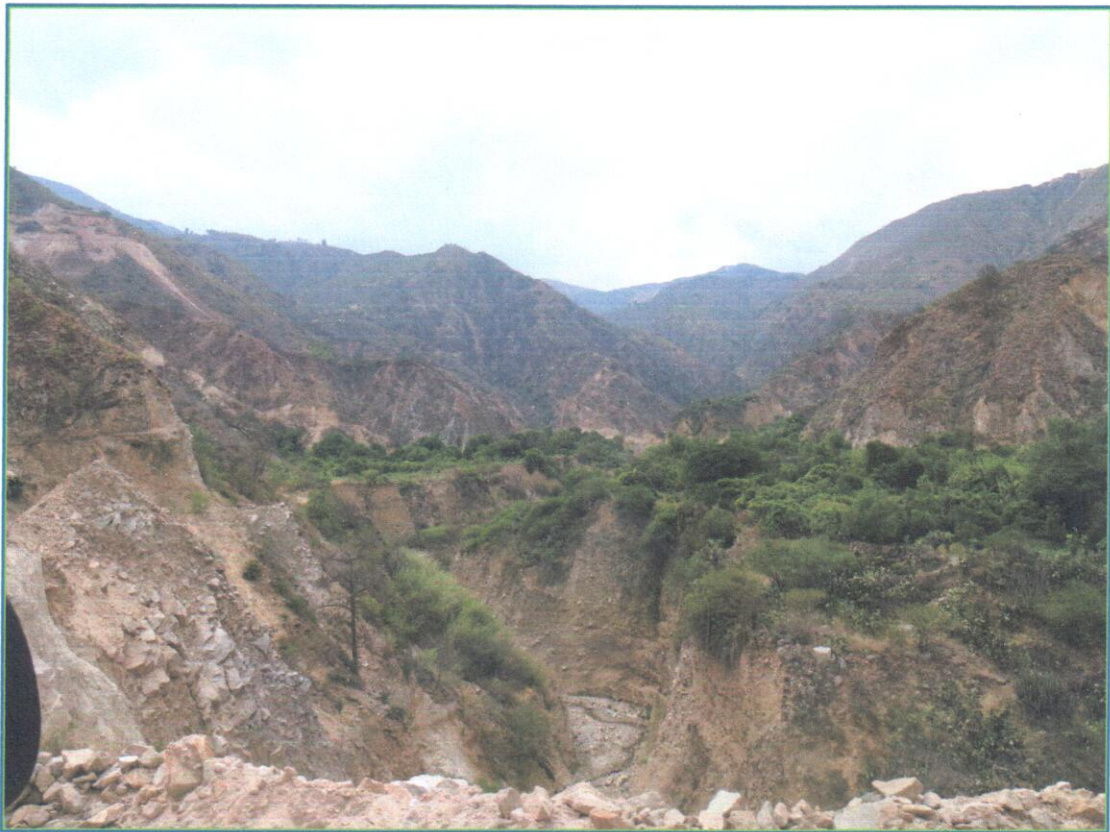
FOTOGRAFIA N° 03: Vista panorámica, del material deslizable, taludes desestabilizadas cauce colmatado, áreas agrícolas en riesgo.
