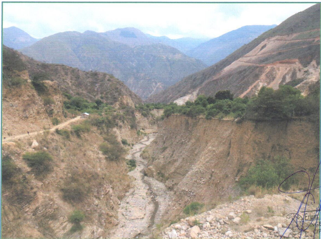
FOTOGRAFIA N° 04: Vista panorámica, del estado actual del cauce, vías de comunicación en riesgo inminente.
