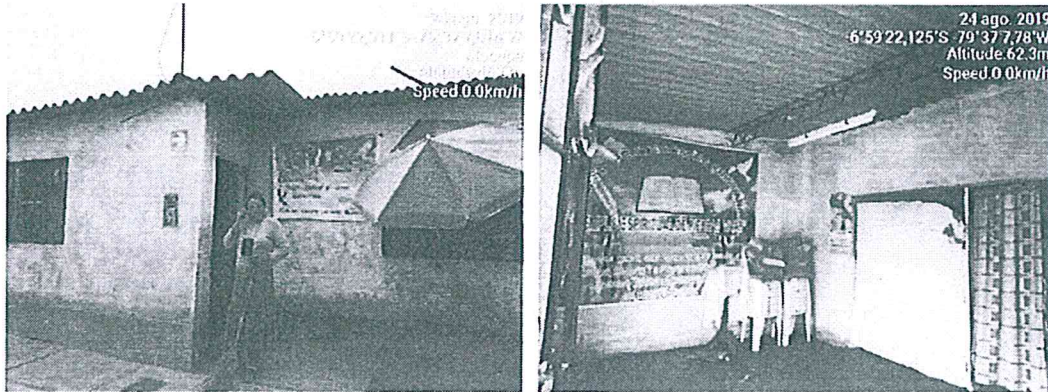
Vivienda Mz.7, Lote 7
