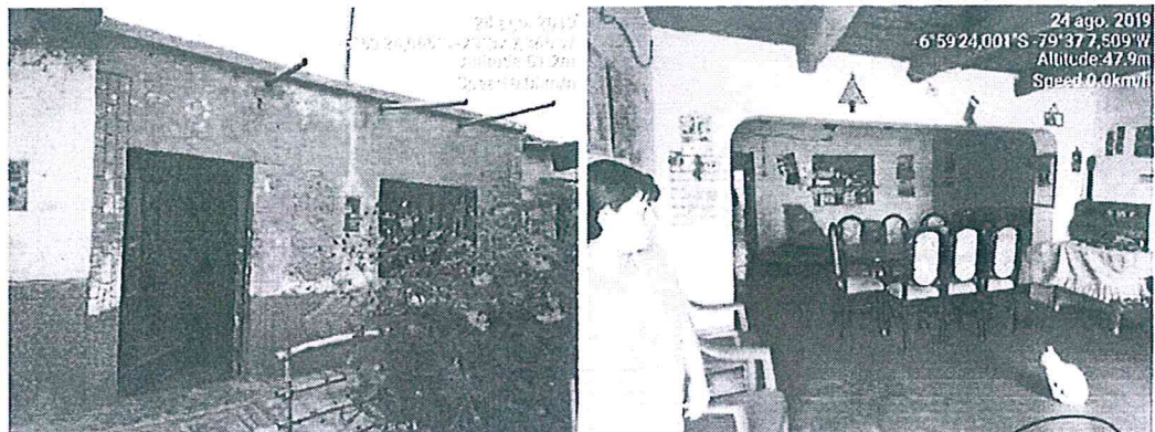
Vivienda Mz.7, Lote 19
