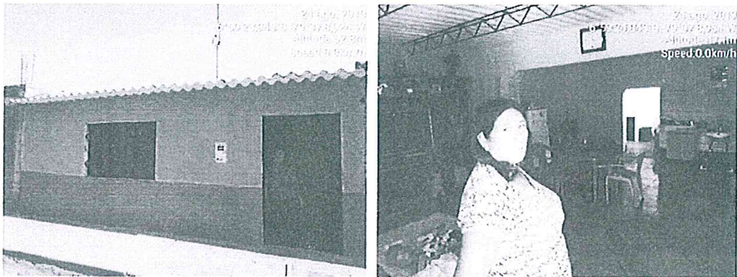
Vivienda Mz.8, Lote 17
