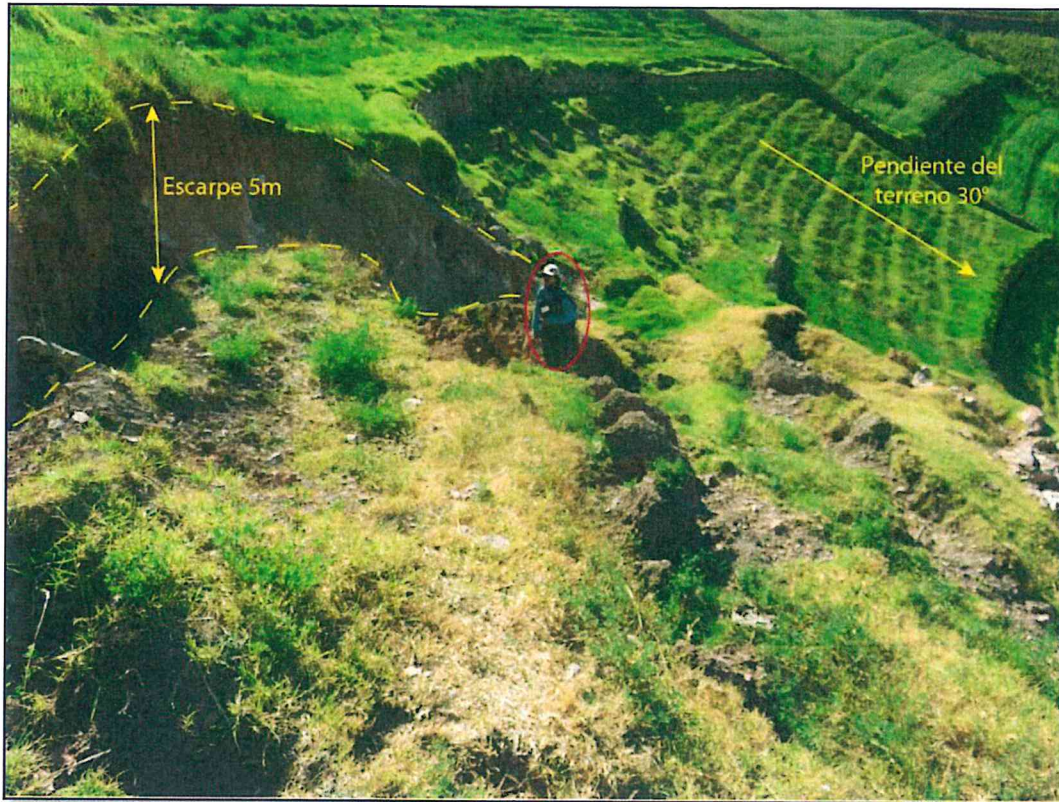
Figura 18. Muestra el deslizamiento rotacional en el sector 1, y el grado de inclinación de la zona.
