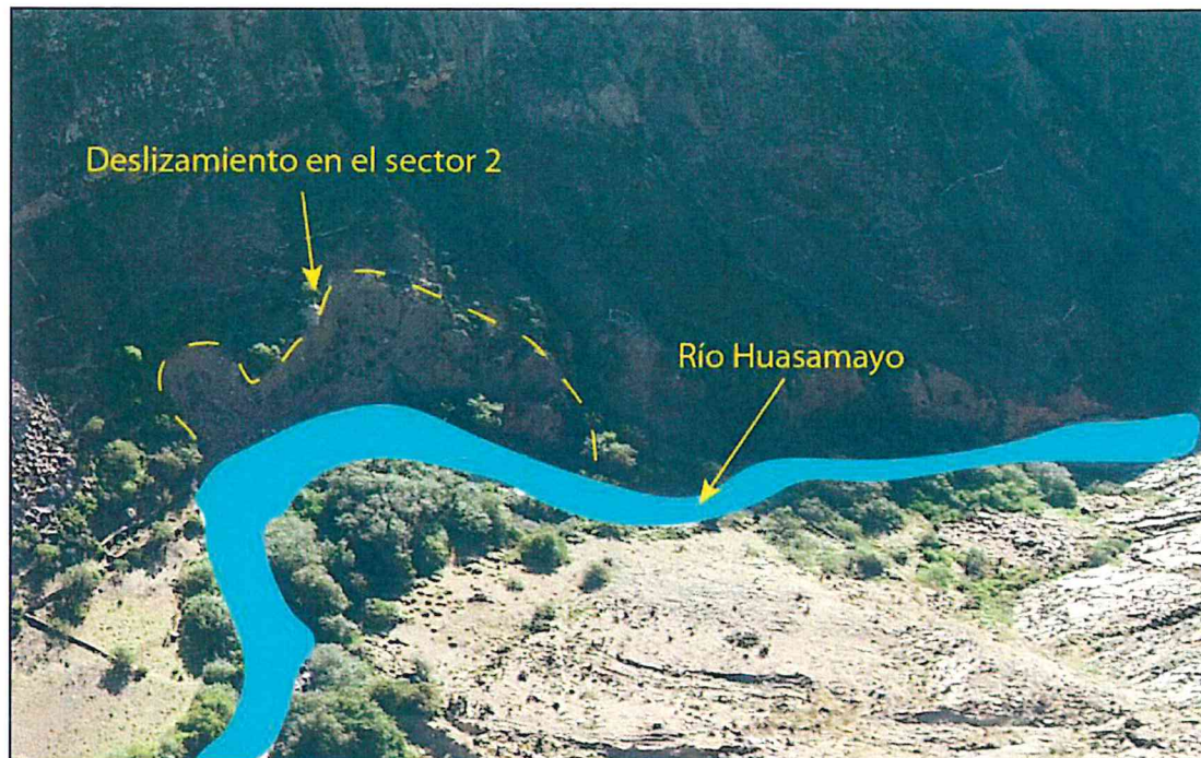
Figura 19. Muestra el deslizamiento rotacional en el sector 2.
