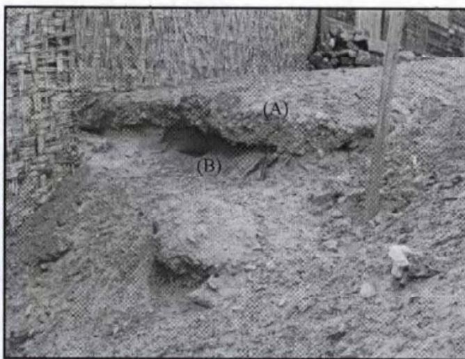
Foto 6.- Se aprecia el material afirmado (A) para el acceso a la calle, y el suelo arenoso (B).
