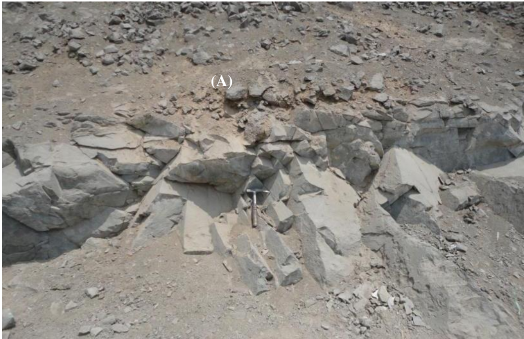
Foto N° 6.- Suelo conformado por bloques, grava, englobados en una matriz areno-limosa (A) y substrato rocoso.
