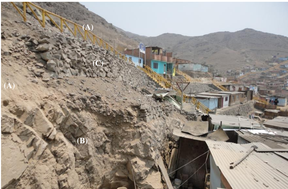
Foto N° 4.- Se muestra las pendientes natural del terreno (A), corte de talud (B), y la formada por la pirca (C).
