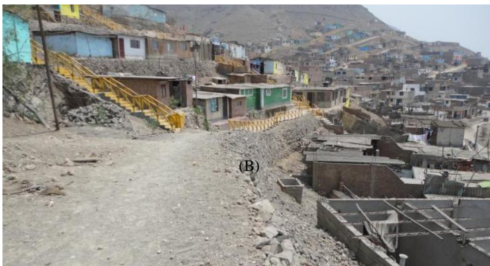
Foto N°7- Construcciones de pircas en los cimientos de viviendas y vías de acceso.
