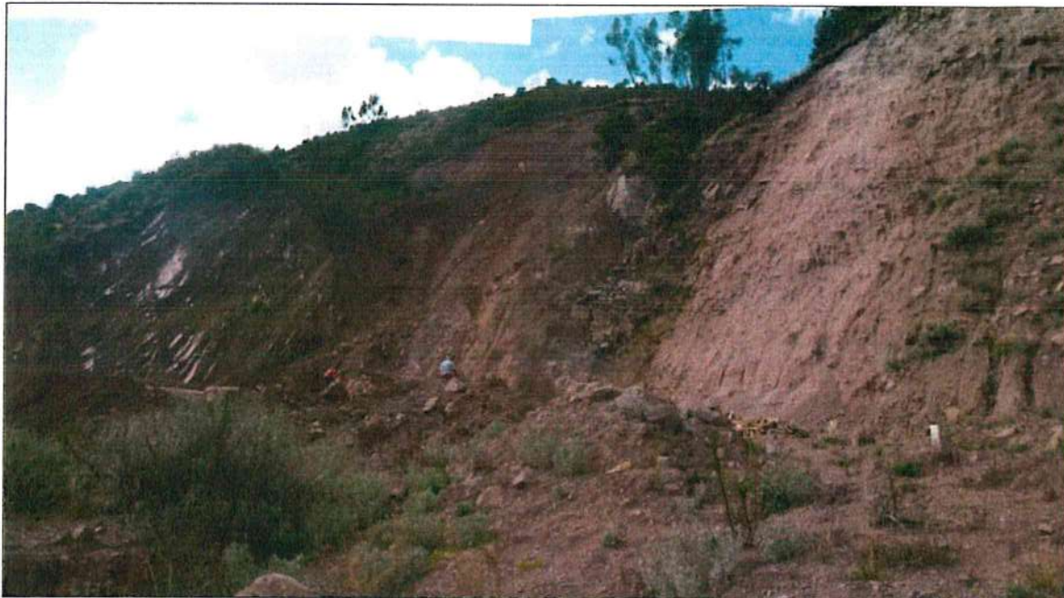
Fotografía 9. Plano frontal del deslizamiento, muestra tres niveles de escarpe
