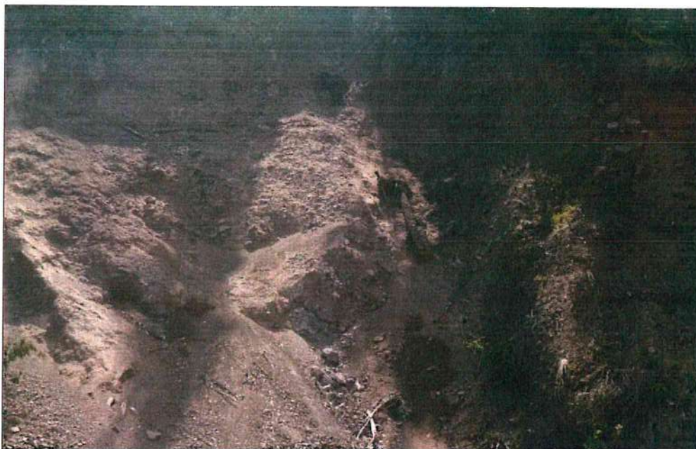
Fotografía 5. Vista de zonas húmedas en el cuerpo del deslizamiento, producto de infiltración de agua
