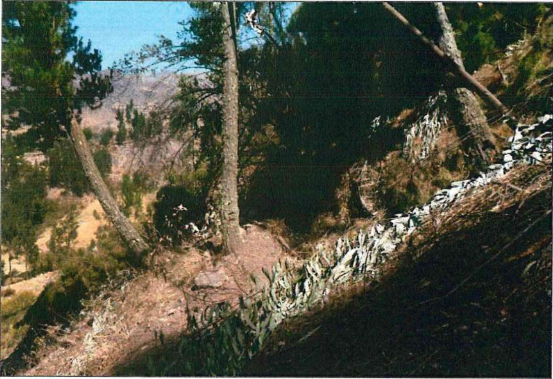
Fotografía 1. Pendiente del terreno, zona superior a la cabecera del deslizamiento, se observa árboles inclinados a favor de la pendiente
