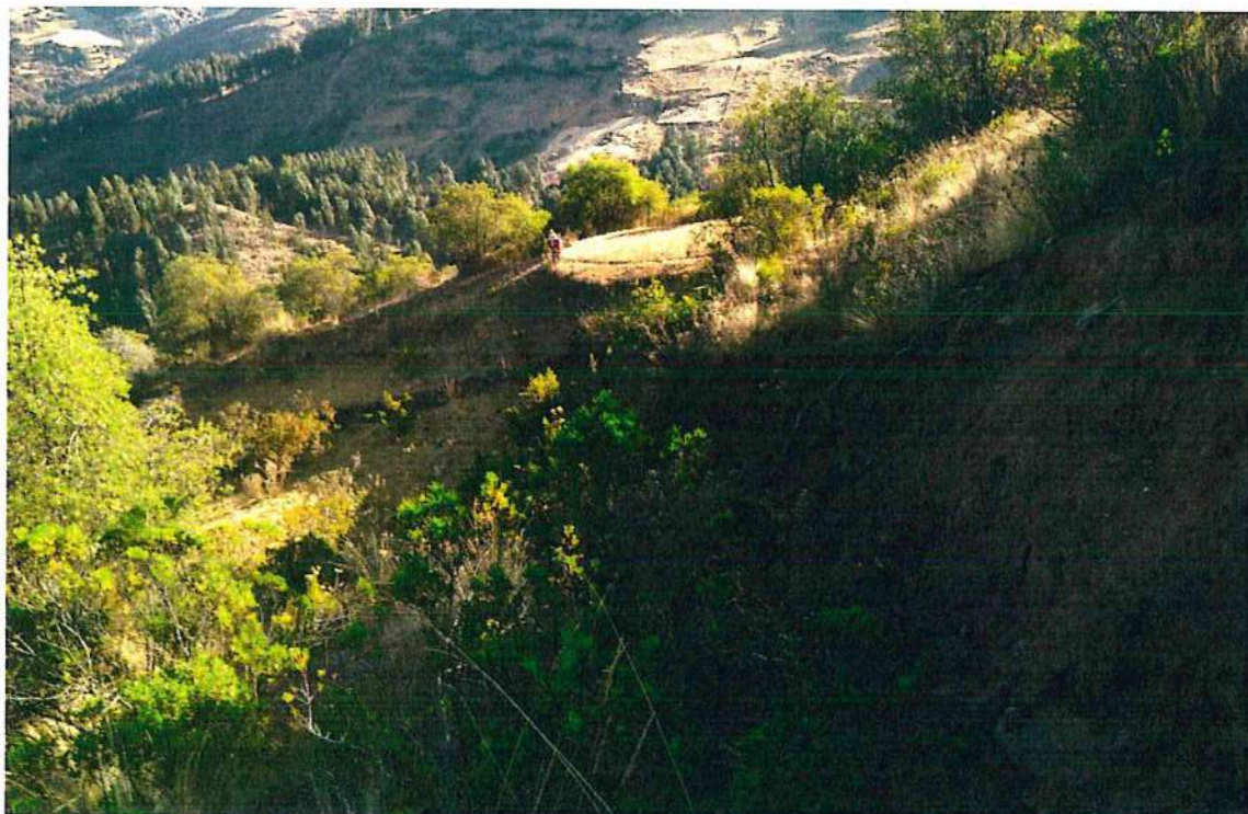
Fotografía 12. Escape del deslizamiento reactivado
