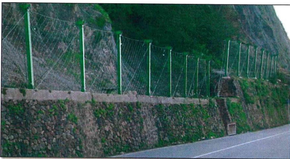
*Figura 21. Ejemplo de mallas dinámicas para caída de rocas.*
