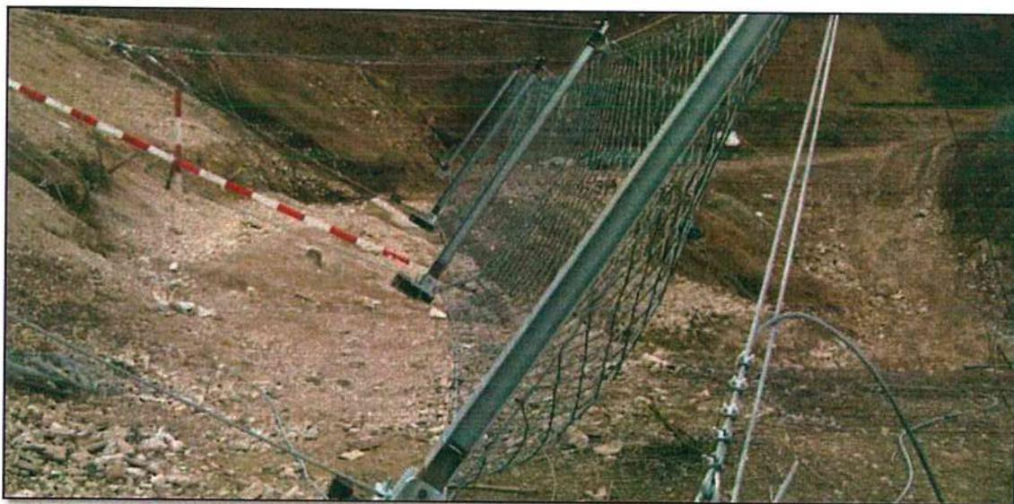
*Figura 22. Ejemplo de mallas dinámicas para caída de rocas.*
