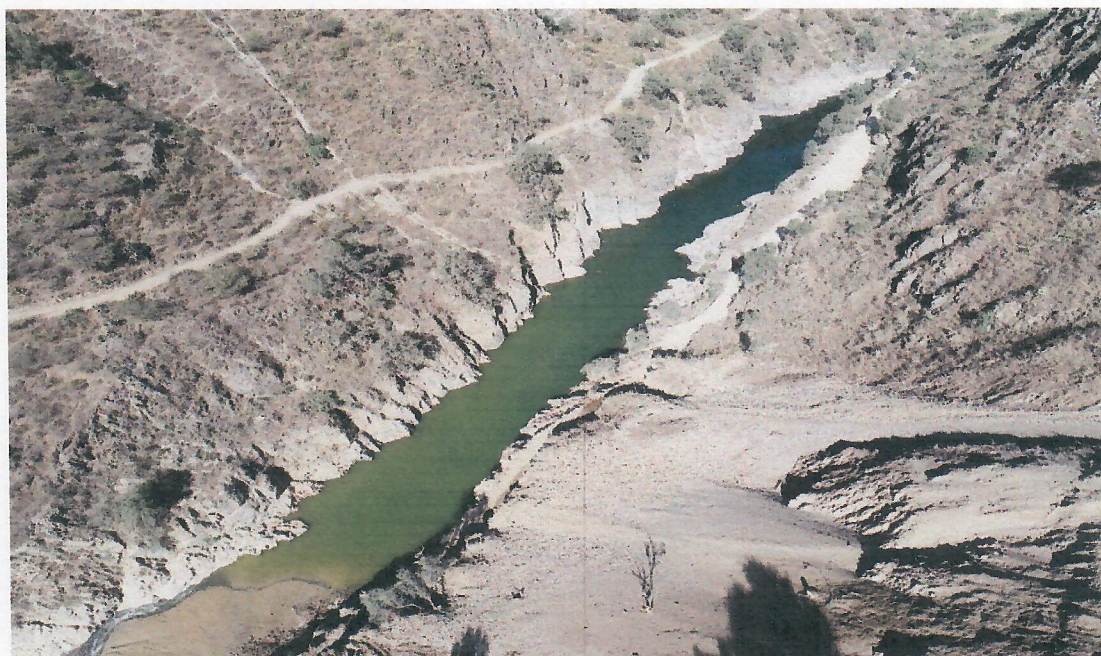
Imagen 06: Fotografía aérea Drone, Acumulación de Material procedente del deslizamiento, pudiendo ocasionar un represamiento del Rio Mantaro si el deslizamiento no es controlado. Fuente: Equipo Técnico GRD.
