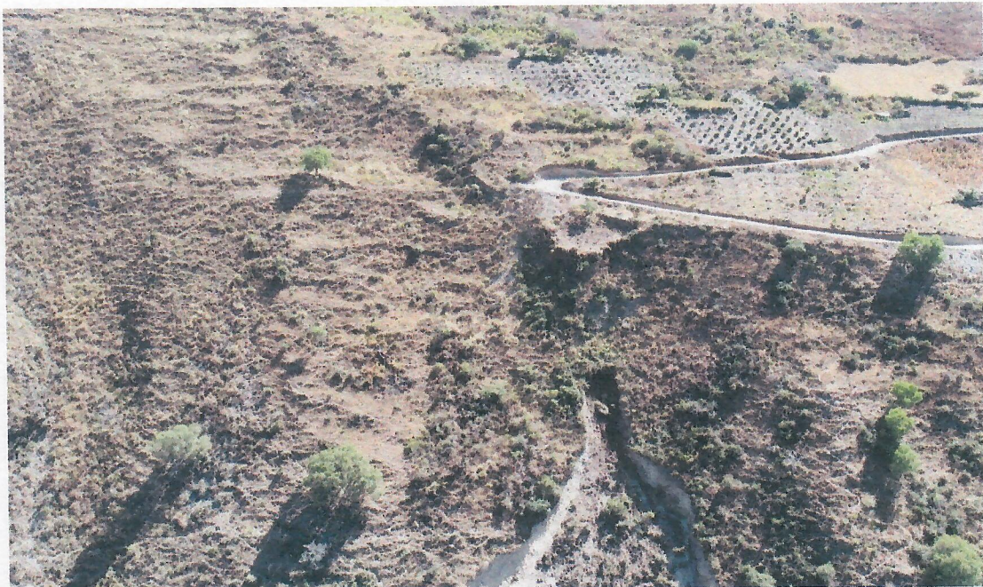
Imagen 07: Fotografía aérea Drone, vista de zonas de plantaciones de Paltos con sistema de riego no capacitado generando filtraciones de agua, producto de ello el deslizamiento Rotacional. Fuente: Equipo Técnico GRD.
