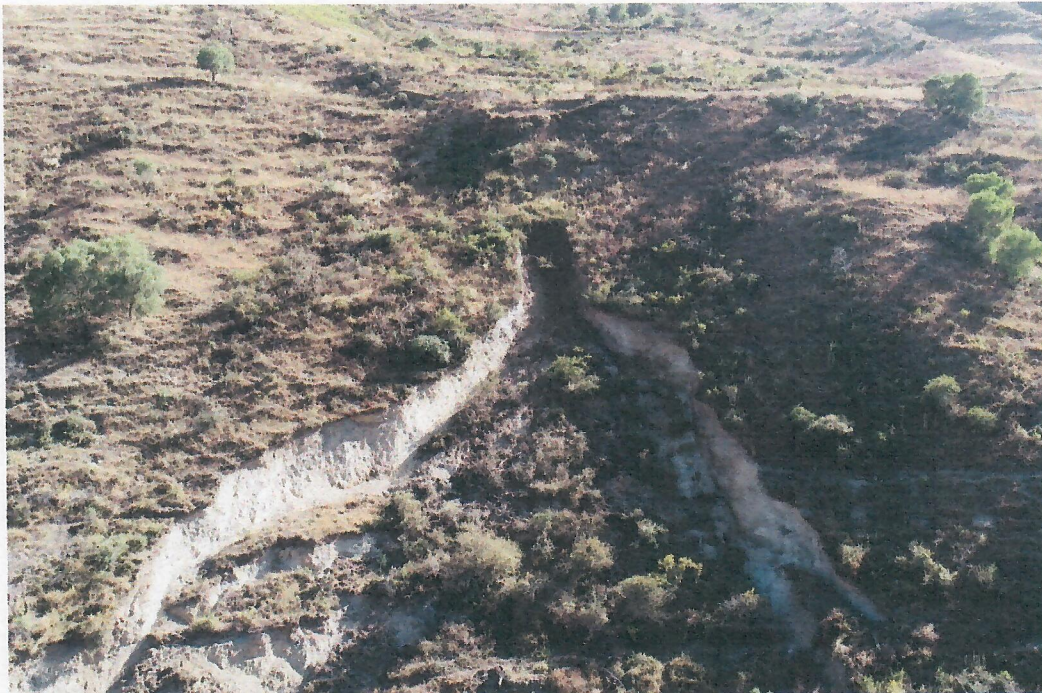
Imagen 03: Fotografía aérea Drone, Deslizamiento Tipo Rotacional del Cerro Huaranway Pampa, Rumbo N75°E, Buzamiento (Inclinación) 65°, Escarpa Principal = 8m. Fuente: Equipo Técnico GRD.
