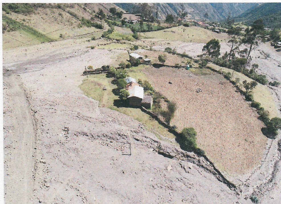
Imagen 20: Elementos expuestos que deben evacuar y declarar zona intangible
