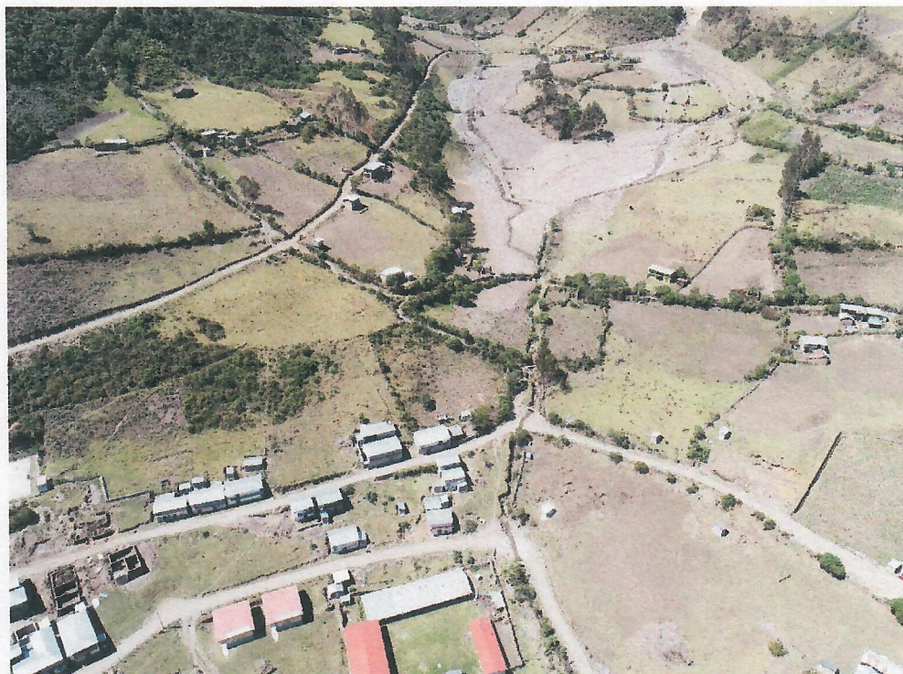
Imagen 19: Se observa el depósito de flujo de detritos en la parte superior
