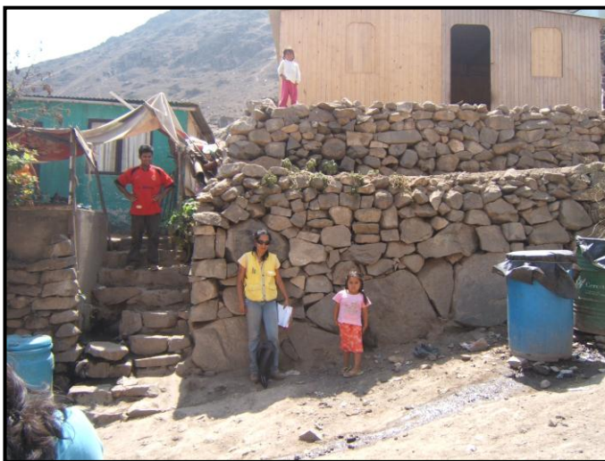
Foto 2.- Lote de la manzana “E” asentada sobre una pirca
