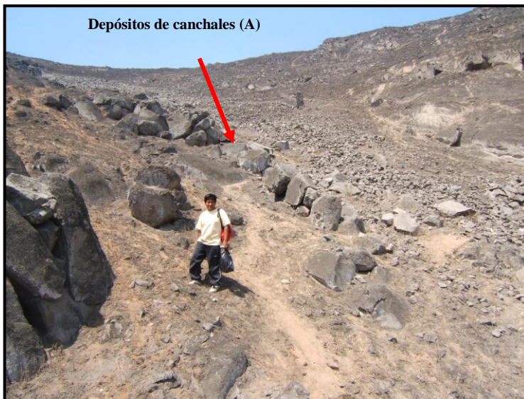
Foto 8.- Depósito de canchales (A) se observan bloques sueltos que pueden generar caída de rocas.
