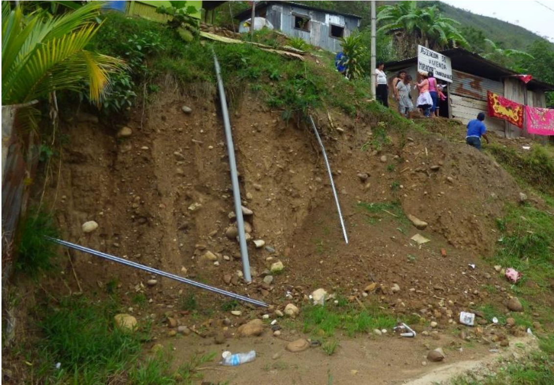
Fotografía 7. En el corte de talud, se aprecia el material del antiguo movimiento en masa, compuesto gravas y bloques dispuestos, en matriz areno-limosa.
