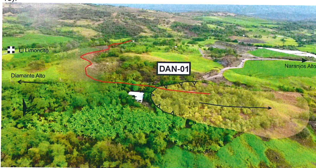
Figura 15. Vista aérea del deslizamiento antiguo que borde la vía afirmada.
