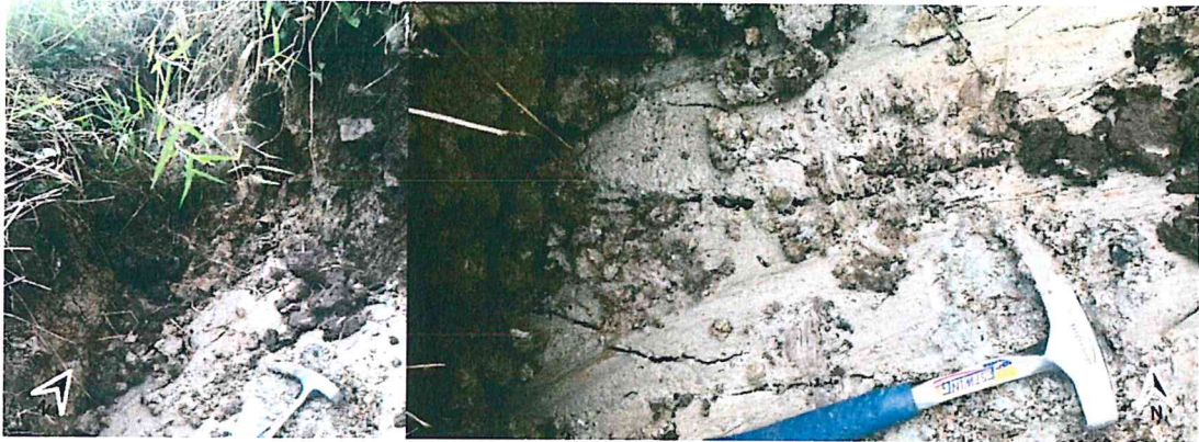
Figura 36. Limoarcillitas sobresaturadas con presencia de estrías de desplazamiento.
