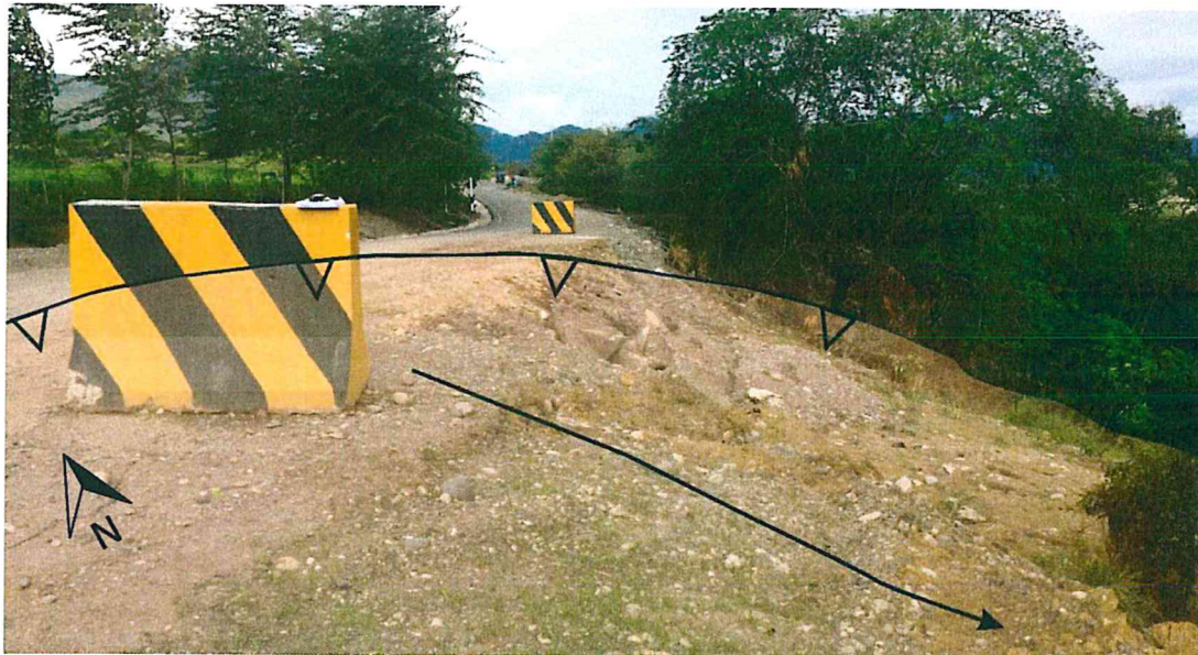
Foto 18. Vía asfaltada Naranjos Alto – Diamante Alto.
