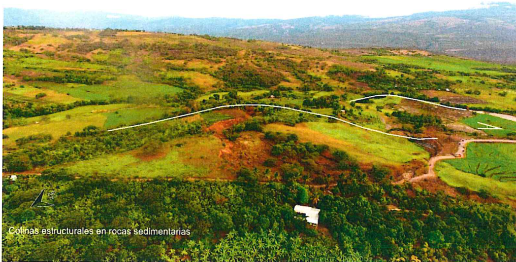
Figura 05. Vista panorámica de la zona del deslizamiento en el sector Limoncito.
