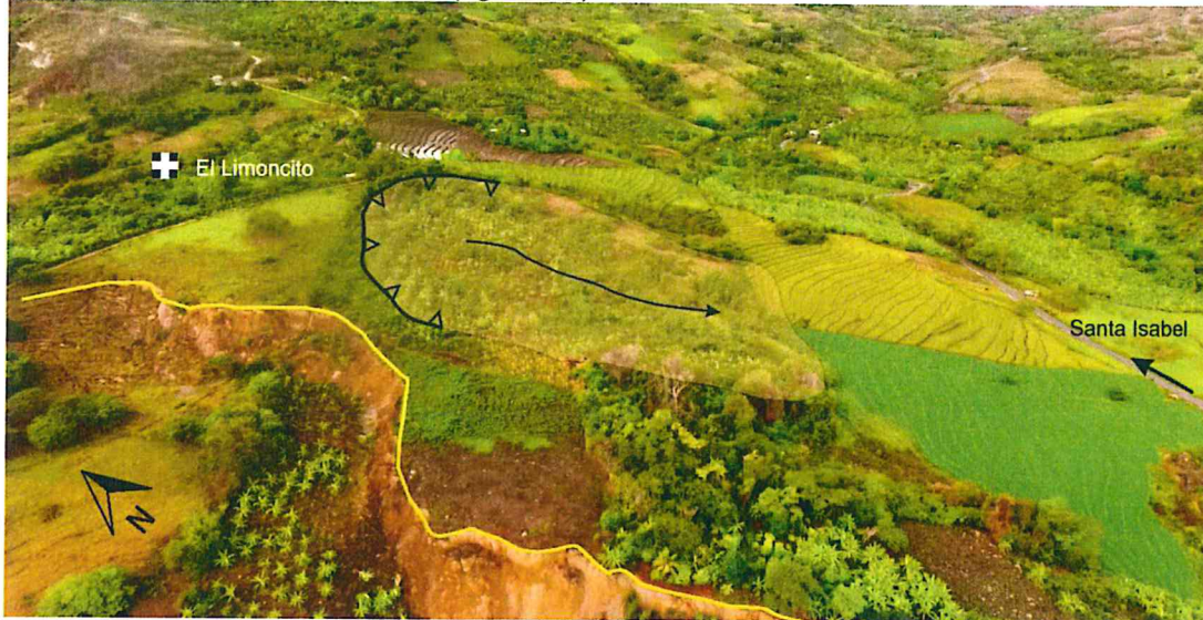
Figura 19. Deslizamiento antiguo al este del escarpe del deslizamiento reciente.
