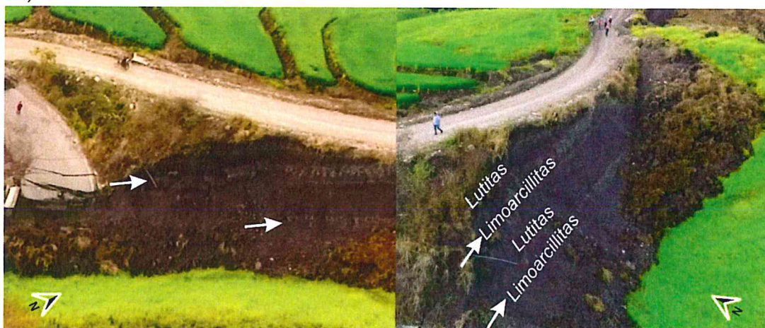
Figura 35. Capas de lutitas y limoarcillitas expuestas en el flanco derecho del deslizamiento.
