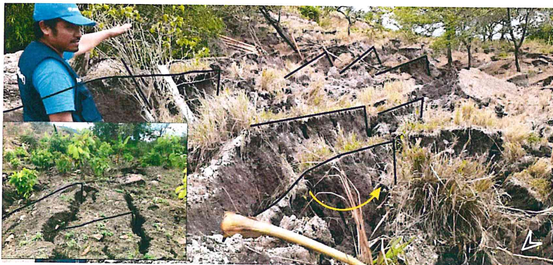
Figura 29. Zona de basculamiento próxima al escarpe del deslizamiento.
