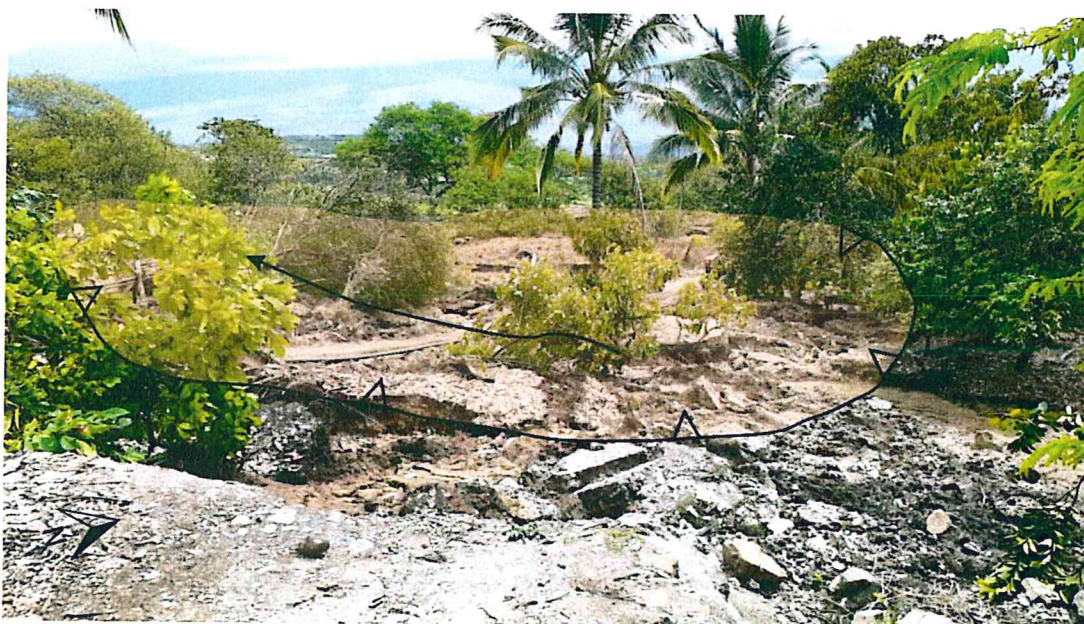
Foto 16. Corona de deslizamiento que fue afectada por el deslizamiento reciente del sector El Limoncito.
