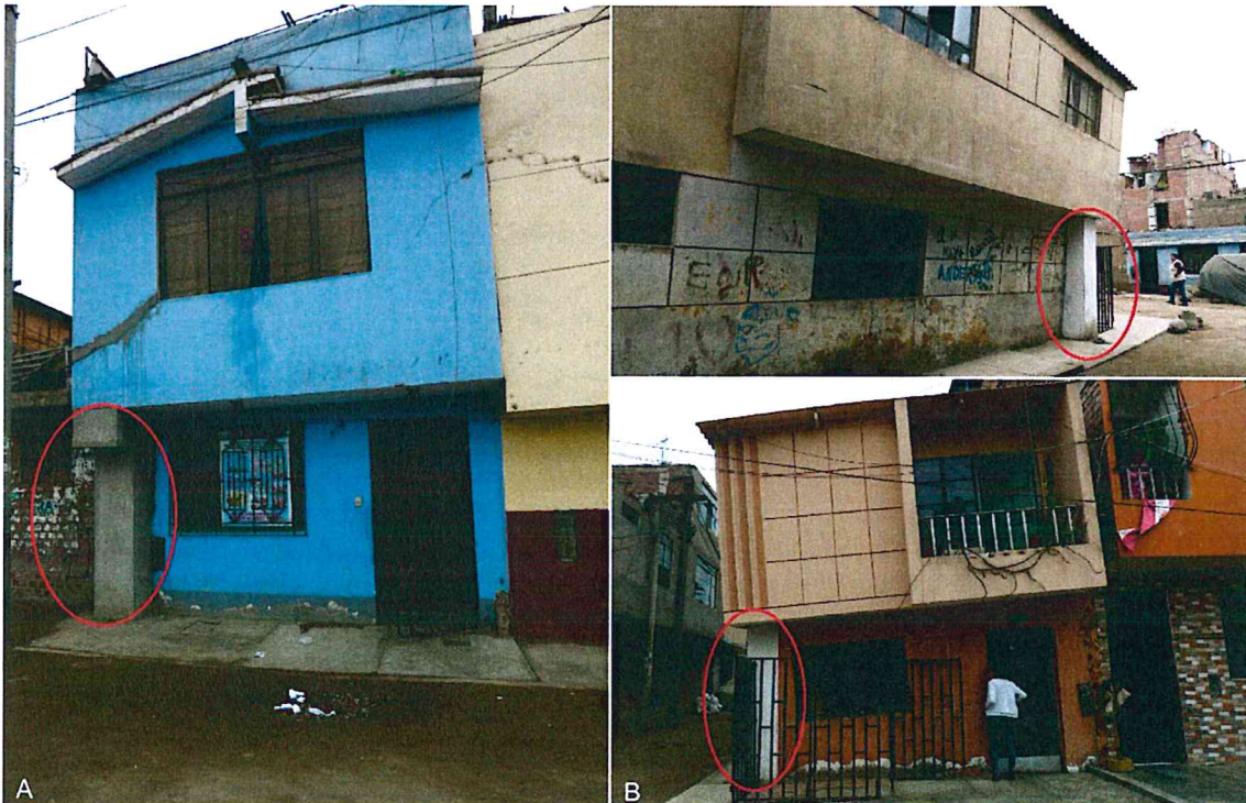
Figura 23 Sostenimiento de viviendas con columnas improvisadas en las viviendas N°305(A) y N°444(B) de la Av. del Trabajo.
