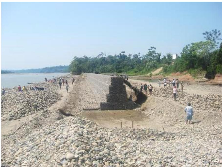
Foto 10b: Gaviones escalonados, construcción
