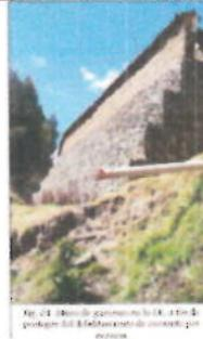
Foto 01: Muro de mampostería de la I.E. que se debilita por el efecto de la erosión.
