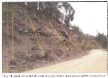
Fig. 01. Talud con estado crítico de erosión forma cárcavas que afecta el tránsito por la vía Acopalca - Colcas.
