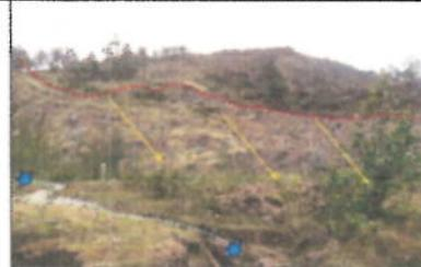
Foto 01: Escarpa con riesgo de deslizamiento debido a la saturación hídrica del talud (segundo nivel) que ocasiona el flujo de lodos.
