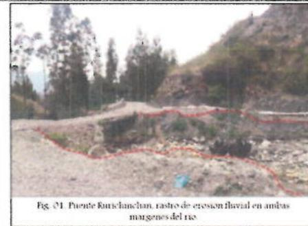
Fig. 01. Puente Rurichinchay, rastro de erosión fluvial en ambos márgenes del río
