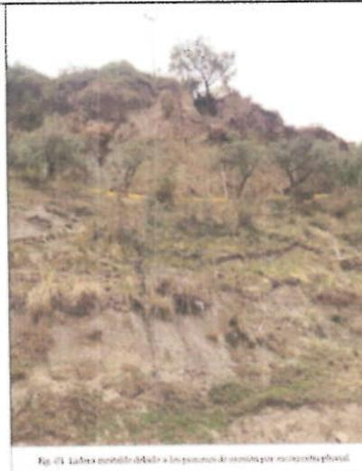
Fig. 01 Talud inestable debido a las personas al tránsito por escorrentía pluvial
