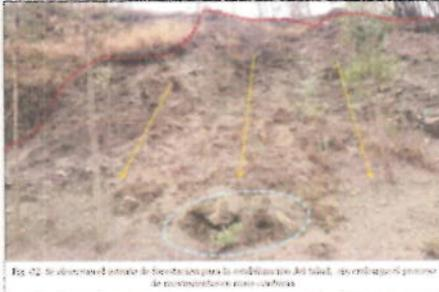
Fig. 02. Se observan el estado de erosión que genera la inestabilidad del talud, generando por procesos de erosión cárcavas.
