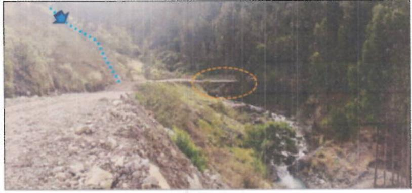
Figura 21. Talud de la carretera Huántar – Chucos – Socoyacu, con rastros de deslizamiento.
