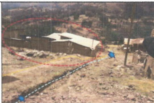
Fig. 01. Canalización del agua de escorrentía pluvial con la finalidad de mitigar el riesgo de inundación.
