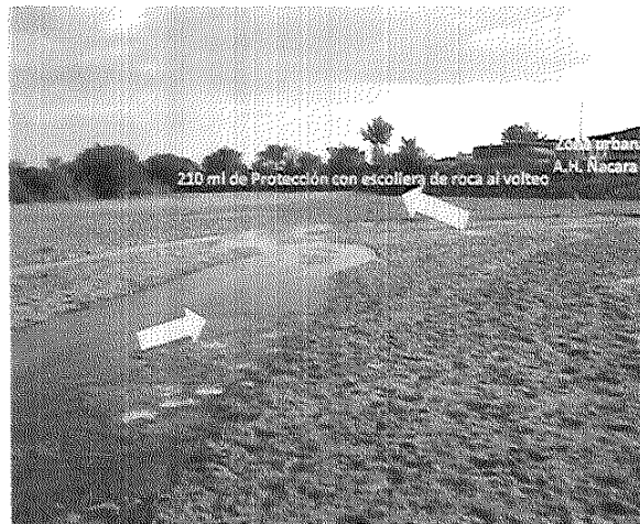
Vista de la protección con escollera de roca al volteo en el A.H. Nácara
