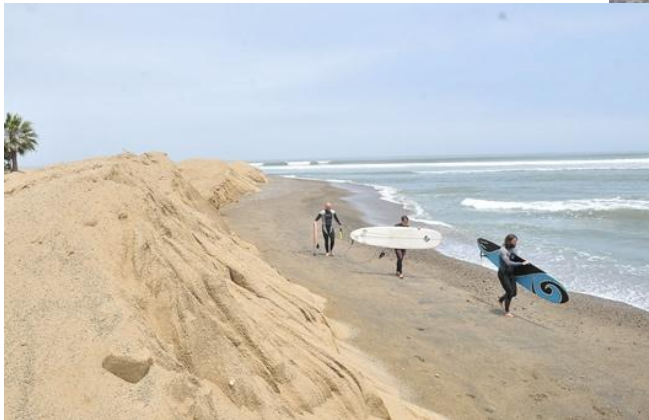
Imagen 18: Medidas adoptadas para contrarrestar las mareas altas (enrocado) - erosión costera (Arenamiento Artificial) - FUENTE: SUB GERENCIA DE RIESGO Y DEFENSA CIVIL
