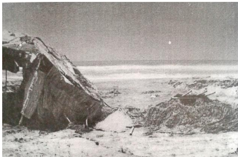
Imagen 12: Estado de las viviendas de totora durante el fenómeno del niño de 1998 - FUENTE: WEB
