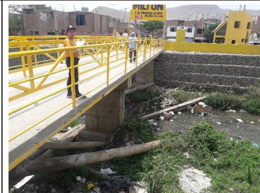
Se evidencia colmatación y vegetación en la margen acumulación de sedimentos y material de arrastre de temporadas anteriores.
