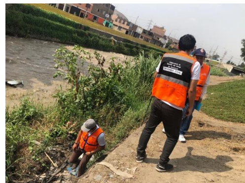
La vegetación y maleza cubre parte de los gaviones antiguos (margen izquierda del rio).
