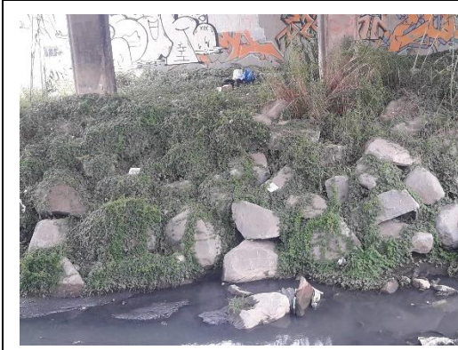
Rocas acomodadas de manera desordenada son cubiertas por la vegetación en la margen izquierda del río.
