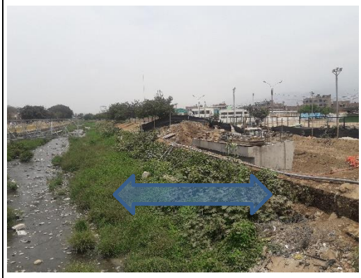
Se evidencia colmatación y vegetación en la margen acumulación de sedimentos y material de arrastre de temporadas anteriores.
