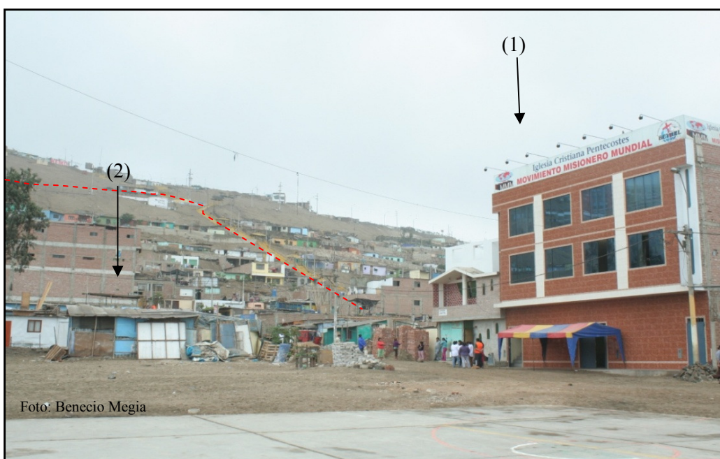
Foto 2.- Se aprecia la manzana “F” (1) y la manzana “I” (2), con pendientes suaves.
