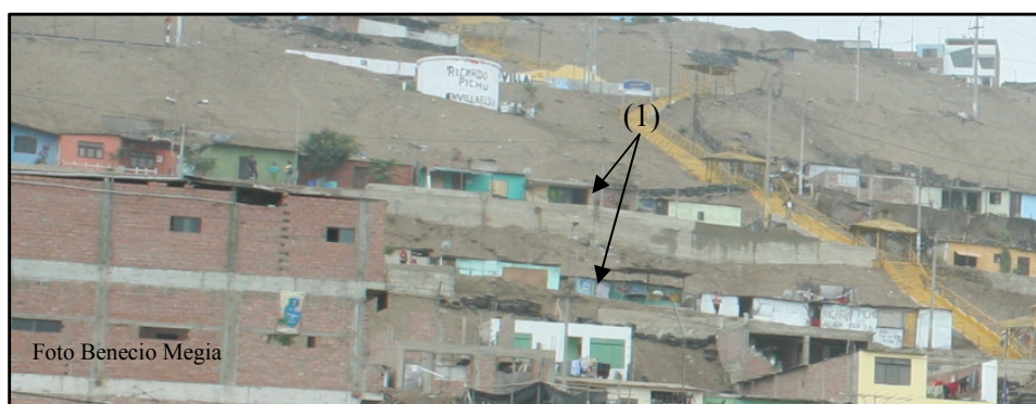
Foto 7.- Muros de contención (1), ubicados entre las manzanas “M” y “L”.
