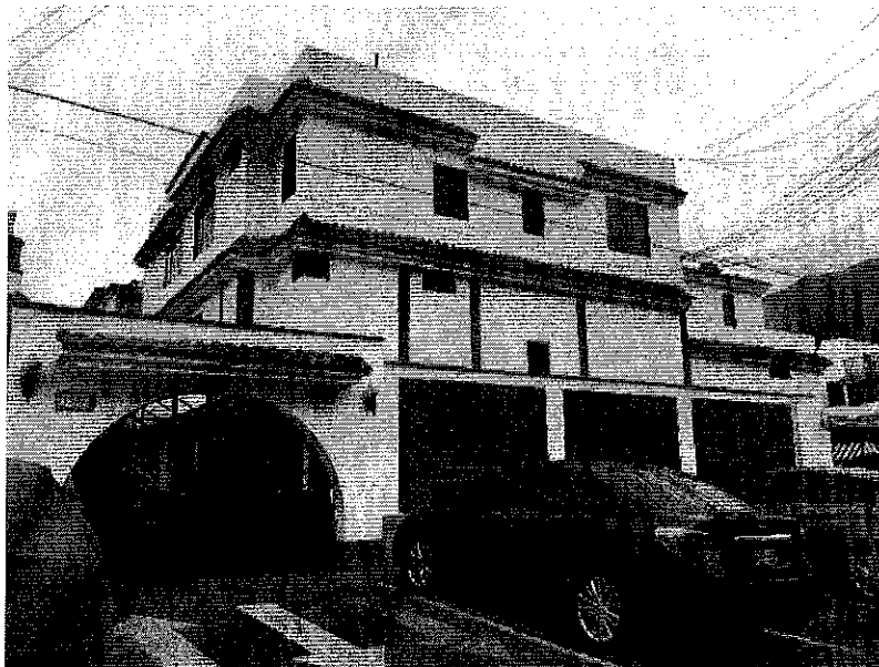
ILUSTRACIÓN N° 2 El sistema estructural más usado, con 70 % de la muestra, es la mampostería de ladrillos de arcilla con diafragmas o techos rígidos
