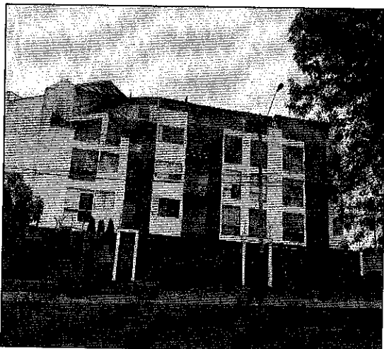
Viviendas de concreto armado de cuatro niveles
