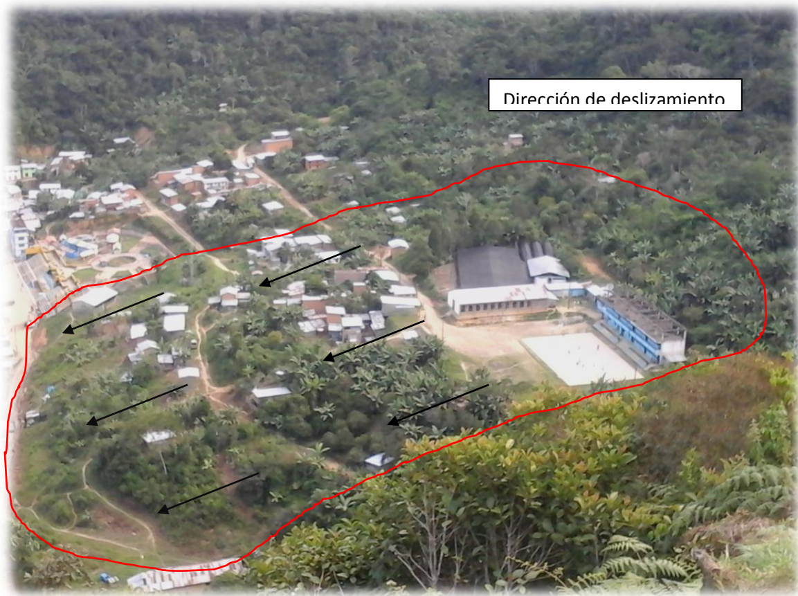
Foto N° 02: Dirección del deslizamiento en la zona afectada del Barrio Selva Alegre.
