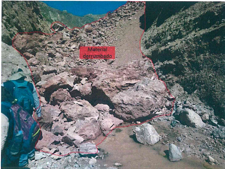
Figura 14. En la quebrada Yarqui mirando aguas arriba, se aprecia el material derrumbado que se generó del cuerpo del deslizamiento, que obstruye el cauce de la quebrada.
