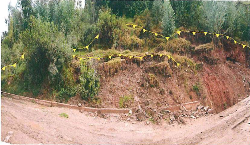
Figura 8. Vista donde se observa escarpas secundarias continuas y presencia de vegetación. Se encuentran en las siguientes coordenadas UTM 8979858 N, 205152 E, con una cota de 2582 m.s.n.m.
