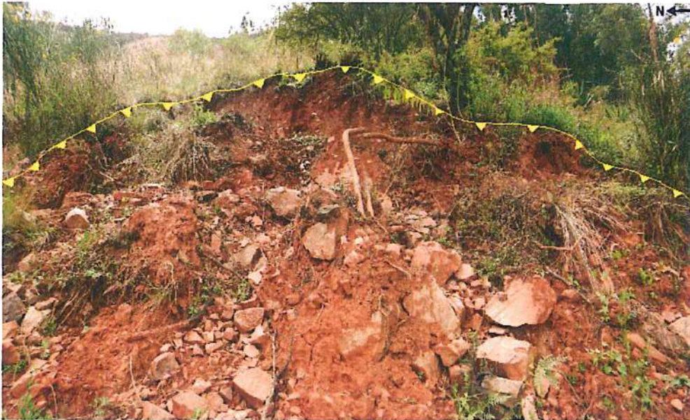
Figura 10. Vista en la que se delimita la escarpa de tipo rotacional, en las siguientes coordenadas UTM 8979839 N, 205348 E, con una cota de 2642.
