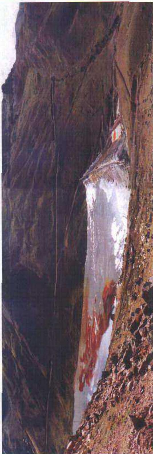
**Foto N° 148** Presa de relave Achula de la Compañía Minera Mimosa, ubicada en la quebrada Yanapacha (Dist. de Ccochaccasa, Huancavelica). Donde se efectúa el tratamiento de aguas ácidas con cal.
