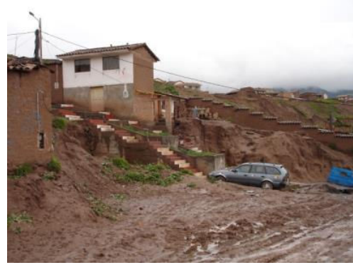
Fotografía 7.7. Sector Altiva canas 16 al Sur oeste del Distrito
