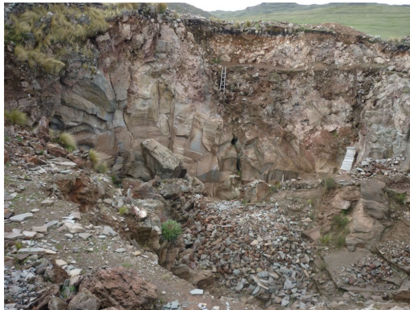
Fotografía 4.4. Canteras de volcánicos de la formación Rumicolca (Huaccoto) nótese el grado de fracturamiento
