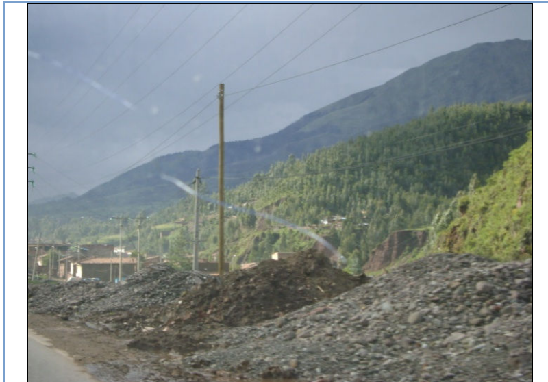
Foto 5.19 Vía Angostura a Saylla disposición de sedimentos extraídos del río
