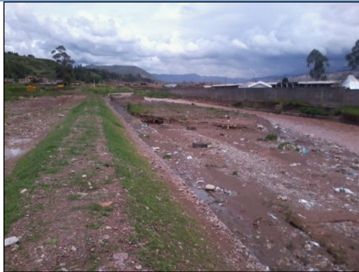
Foto 5.18 Acumulación de sedimentos en la zona de Kayra
