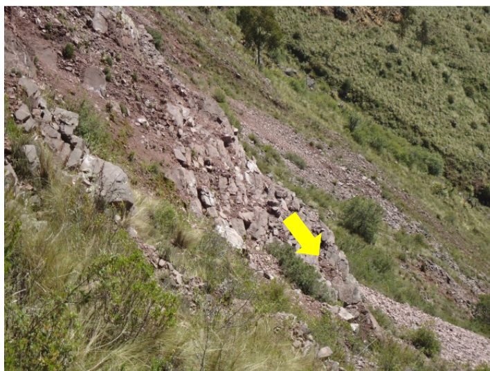
Foto 5.15 Vista lateral de la zona, mostrando la cantidad de material caído.
