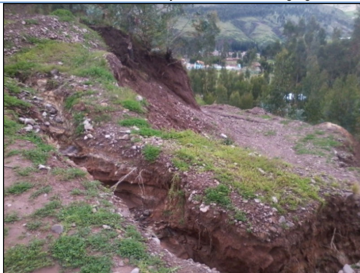
Foto 5.32 Frente de trabajo de la cantera de agregados.
