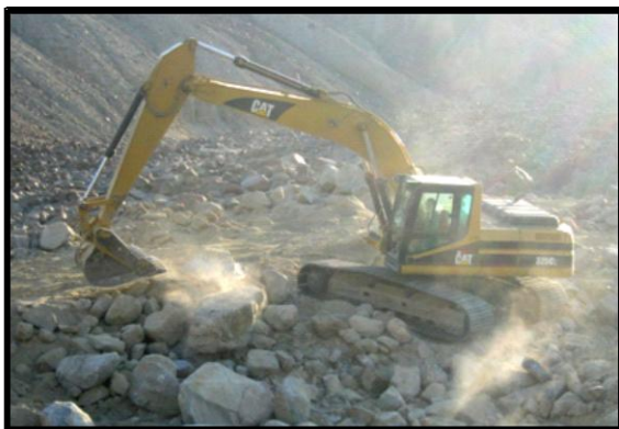
Extracción, Selección y Acopio de Roca
