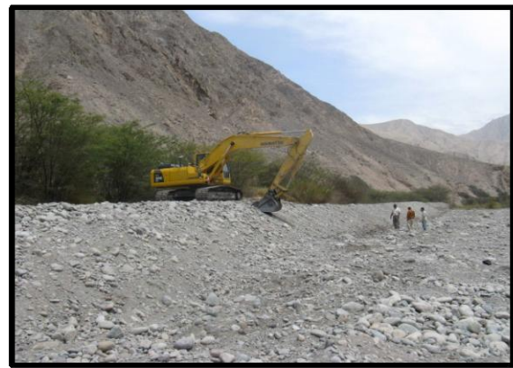
Perfilado de Talud
