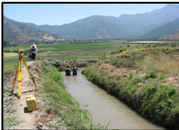
Trazo, Replanteo y Control de Trabajo
