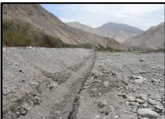
Excavación de Uña para Enrocado
