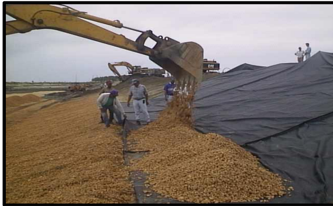
Geotextil de 200 gr/cm 2 . Suministro e Instalacion
