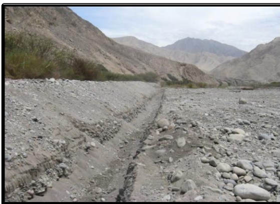
Excavación de Uña para Enrocado
