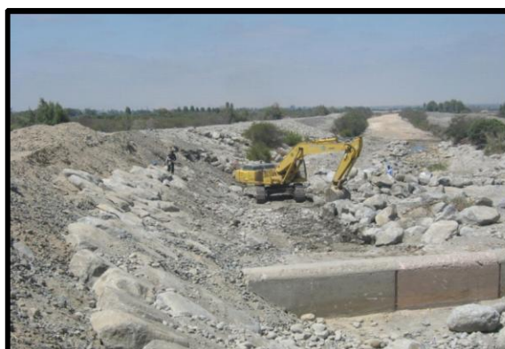
Acomodado de roca en Talud
