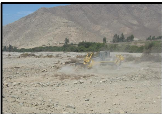
Encauzamiento y/o Descolmatación de cauce
