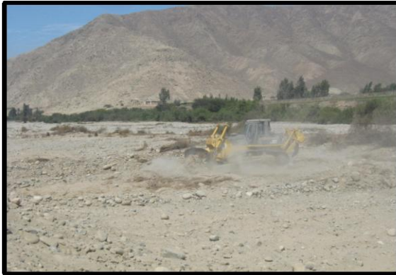
Encauzamiento y/o Descolmatación de cauce
