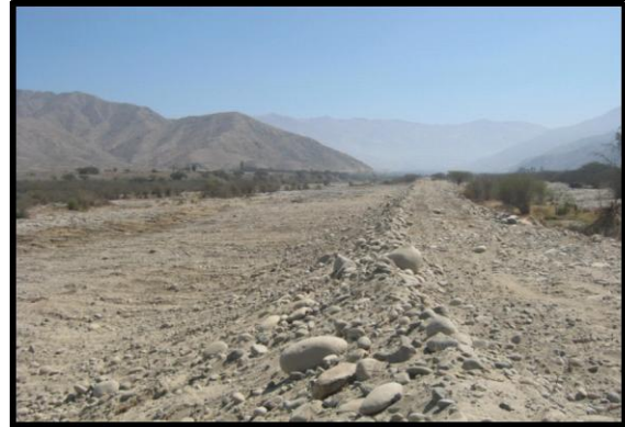
Conformación de Dique con Material Propio
