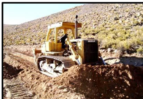
Mejoramiento de Camino de Accesos
