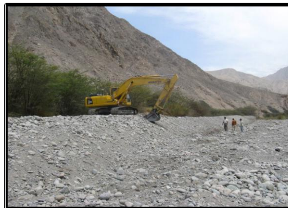
Perfilado de Talud
