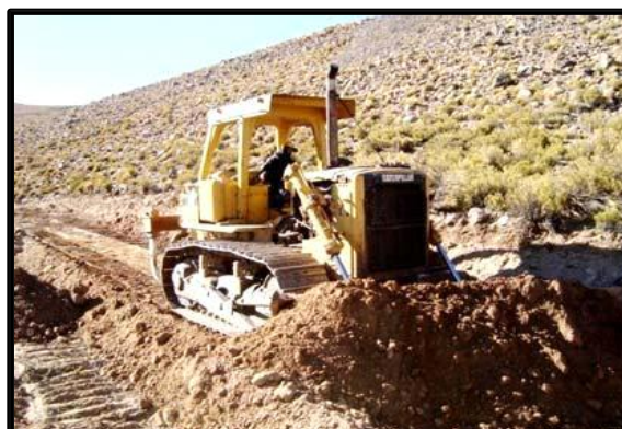
Mejoramiento de Camino de Accesos
