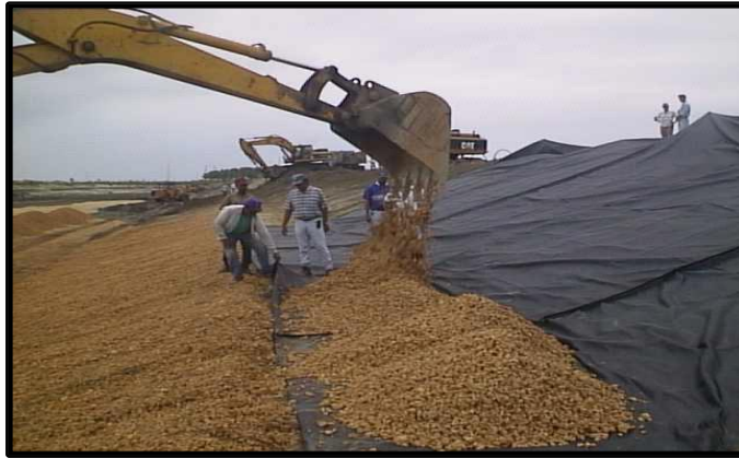
Geotextil de 300 gr/cm 2 , Suministro e Instalacion
