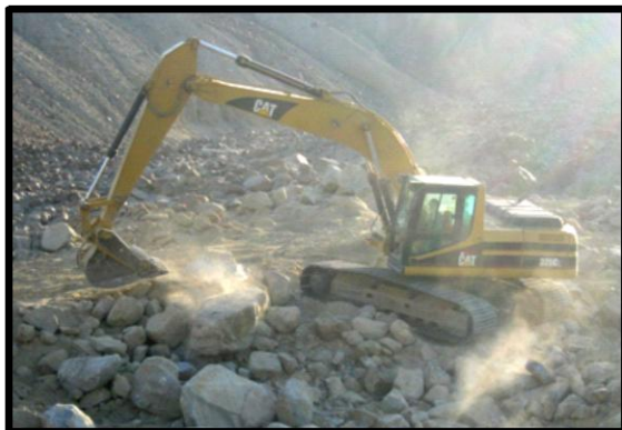
Extracción, Selección y Acopio de Roca
