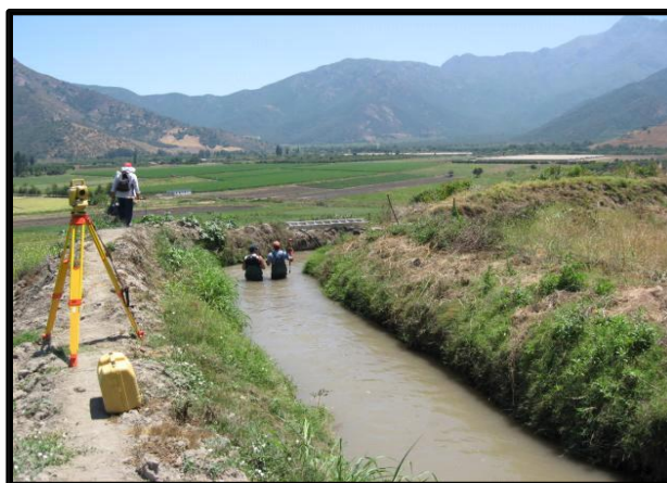
Trazo, Replanteo y Control de Trabajo
