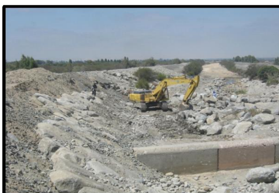
Acomodado de roca en Talud
