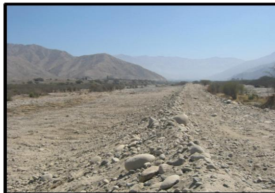
Conformación de Dique con Material Propio
