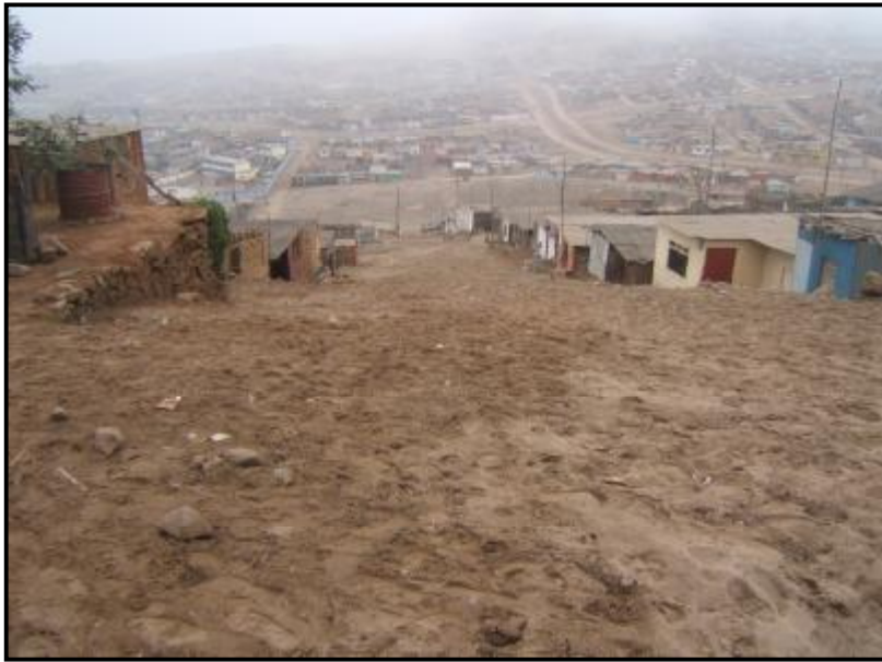
Foto 2.-Vista de la manzana “E” y “F” sector oeste del AA.HH. 12 de Diciembre, donde se puede distinguir una pendiente mayor de 10°.
