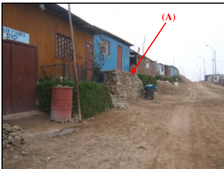
Foto 10.- Vista de la Calle Tupac Amaru, se observa una vivienda, donde su pirca (A) tiene una altura hasta de 1 m.
