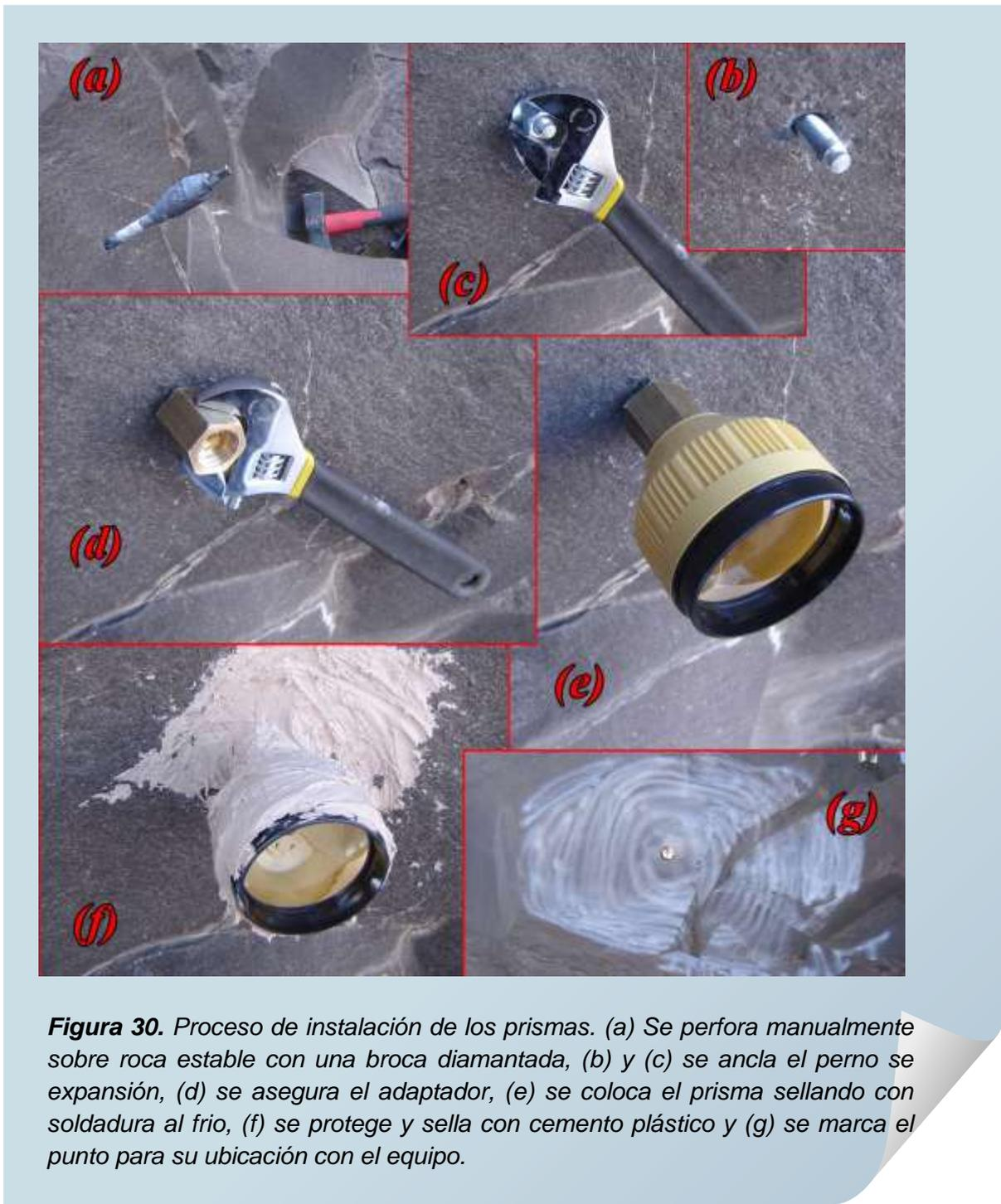
**Figura 30.** Proceso de instalación de los prismas. (a) Se perfora manualmente sobre roca estable con una broca diamantada, (b) y (c) se ancla el perno se expansión, (d) se asegura el adaptador, (e) se coloca el prisma sellando con soldadura al frío, (f) se protege y sella con cemento plástico y (g) se marca el punto para su ubicación con el equipo.
