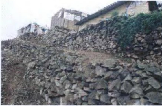
F 10. Terraplenes Mz. C, y pasaje "Los Ficus".
