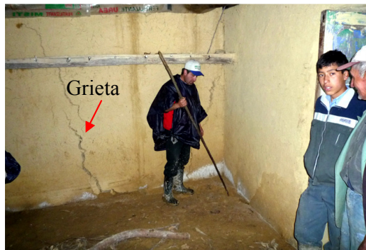
Foto 21 y 22: Exteriores de vivienda de tapial ubicada dentro de zona afectada por flujo de tierra. Interior de la vivienda, donde se observan las grietas formadas en paredes y pisos que hicieron inhabitable el inmueble.
