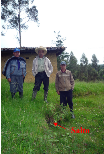
Foto 16: Formación de escarpa de 0,50 m de salto principal, ubicada sobre la escarpa principal del movimiento compuesto, evidencia que el evento es retrogresivo.
