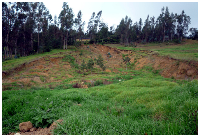
Foto 14: Vista ladera arriba, del deslizamiento-flujo de tierra en el sector de Chahuar-Tugusa, obsérvese la vivienda ubicada por encima de la escarpa.
