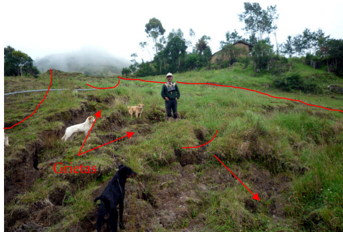
Foto 18: Vista ladera arriba del deslizamiento-flujo de tierra del sector de Macma, se observa el terreno irregular y la formación de agrietamientos con saltos de 0,40 m.
