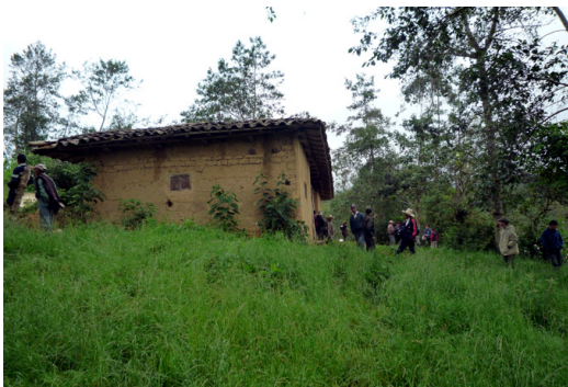
Foto 21 y 22: Exteriores de vivienda de tapial ubicada dentro de zona afectada por flujo de tierra. Interior de la vivienda, donde se observan las grietas formadas en paredes y pisos que hicieron inhabitable el inmueble.
