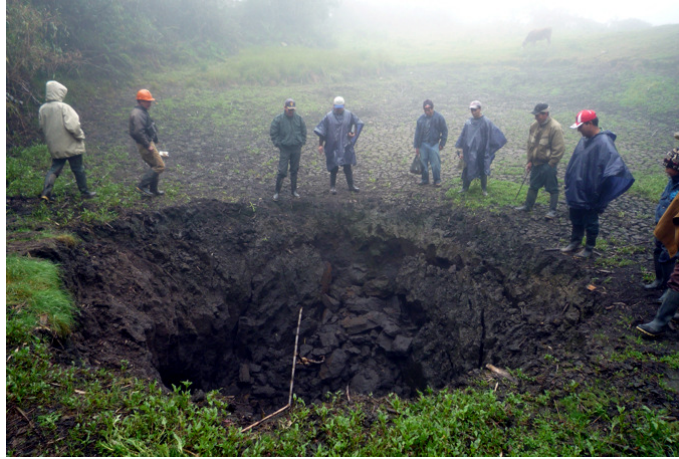
Foto 24: Detalle del agujero abierto por el colapso del fondo de laguna, que vendría ser el techo de caverna, en el sector de laguna Negra.
