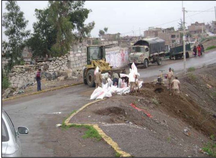
Fotos N° 12. Se observa la vía dañada del Puente del Ejército, en la cual se desarrollan trabajos de relleno para instalar una geomembrana.
