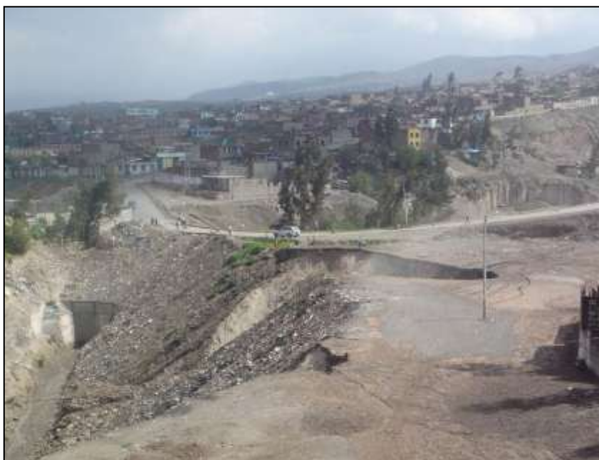
Foto N°1.- Vista de la zona del Puente del Ejército y sus accesos.
