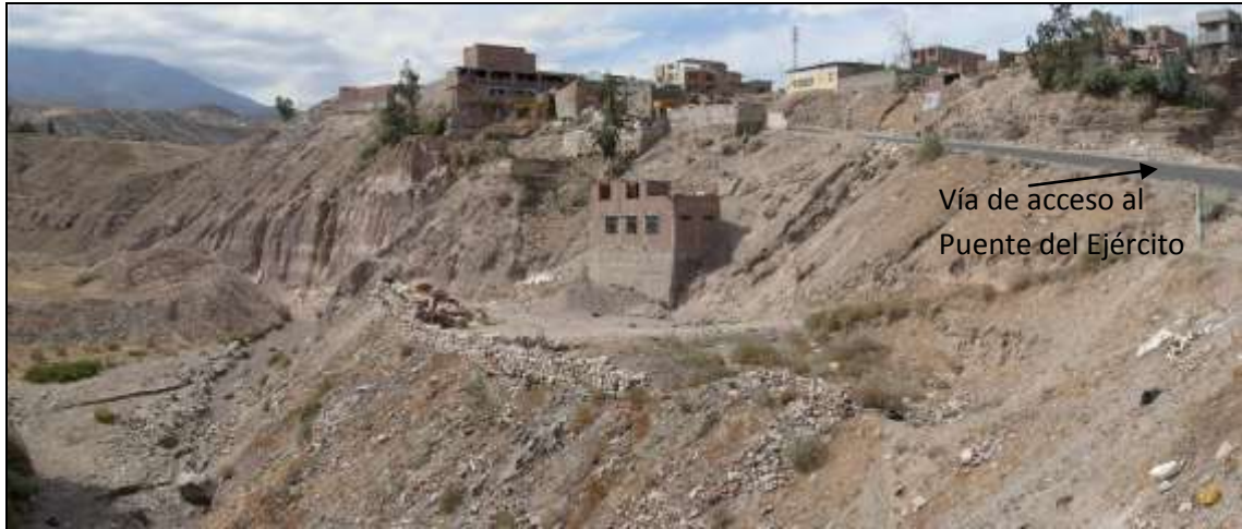
Foto N° 4. Vista de la ladera sobre la cual se localiza la vía de acceso del Puente del Ejército (margen izquierda de la quebrada Huarangueros).
