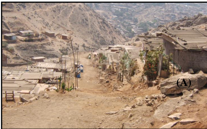
Foto 2.- Manzana “R”, muestra la pendiente del terreno y parte de los bloques de la antigua caída de roca (A).
