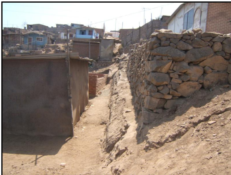
Foto 8.- Sector de la manzana “LL”, donde se muestra una pirca con altura hasta de 1,80 m. La cual fue levantada para nivelar el terreno.
