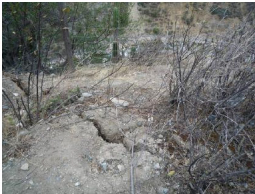
Foto 8. Otra grieta en el cuerpo del deslizamiento. Obsérvese el enrejado que ha sido colocado para impedir el avance del deslizamiento.
