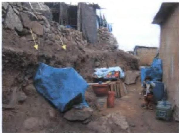
En la foto n° 12 se observa el corte de talud de 2,7 m altura y la pirca al borde de 1 a 1,3 m; la foto n° 13 se observa una vivienda de material noble sobre un terraplén mal compactado que termina en pirca sin adhesión; y en la foto n° 14 una pirca sin adhesión al borde del talud del lote inferior, lo cual representa un alto riesgo.
