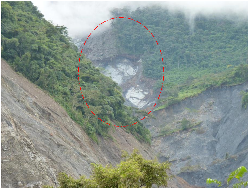
Foto 01: Vista de los estratos de pizarra casi verticales que condicionaron la rotura.
