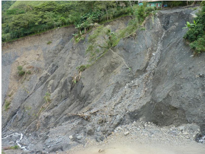
Foto 07: Erosión y derrumbes en la quebrada Ayancate con más de 15 metros de alto.
