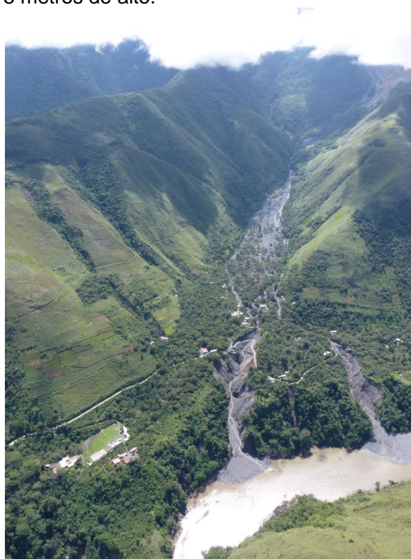
Foto 08: Vista aérea de la quebrada Ayancate, nótese como el flujo se dispersó en la parte media y generó dos “brazos”, así como dos abanicos de detritos.
