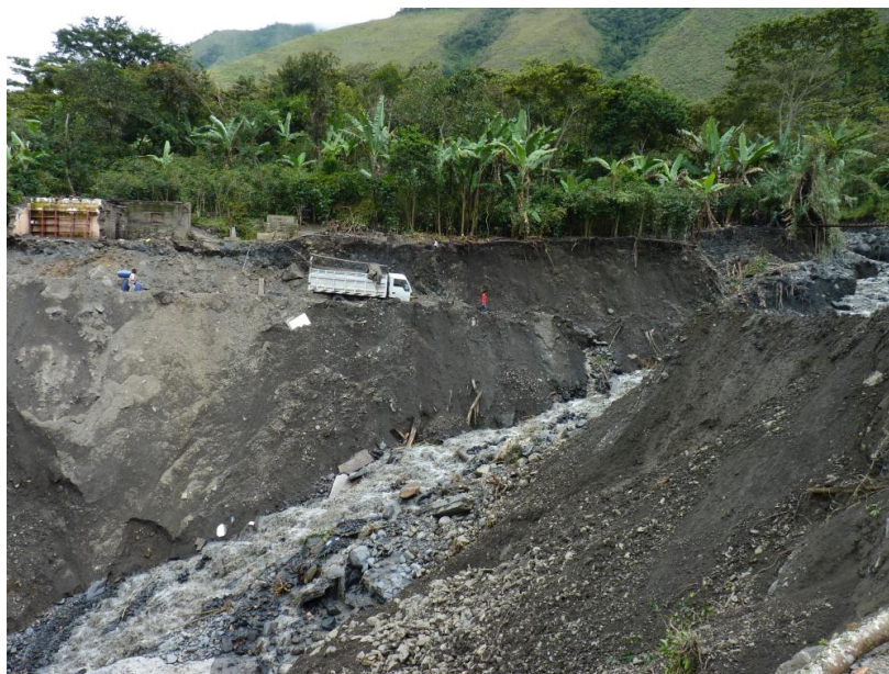
Foto 06: Incisión y derrumbes en la quebrada Ayancate causada por la erosión lateral del flujo de detritos.
