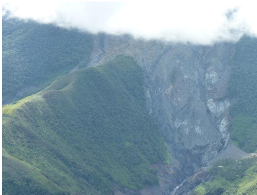
Foto 02: Vista parcial de la zona de arranque del deslizamiento de Mesacancha.
