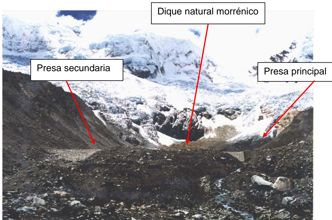
FOTO 03 : Dique morrénico de la laguna Palcacocha antes de producirse el desborde. En el lado izquierdo de la foto se observa una presa de contención de roca asentada, a la derecha la presa artificial y canal de desagüe.
