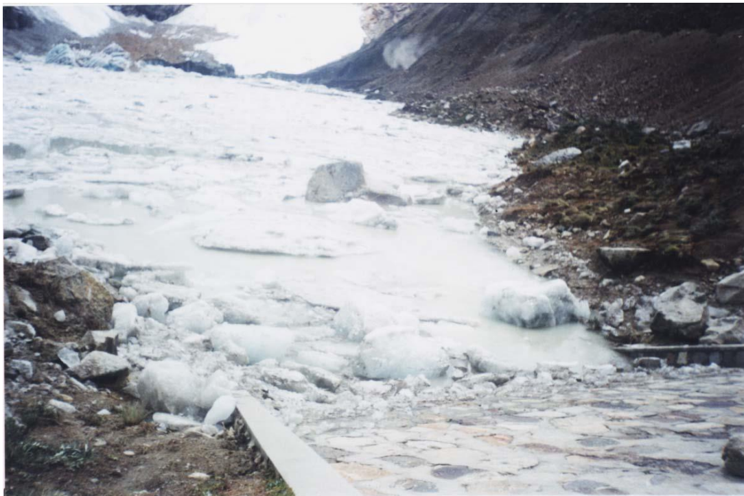
FOTO 10 : La laguna palcacocha, el área de ingreso al ducto y el talud interior de la presa de seguridad. En la vista (21 de Marzo), el nivel del agua se encontraba a 4 m. por encima de la rasante del ducto cubierto. La presa tiene una altura de 8 m.
