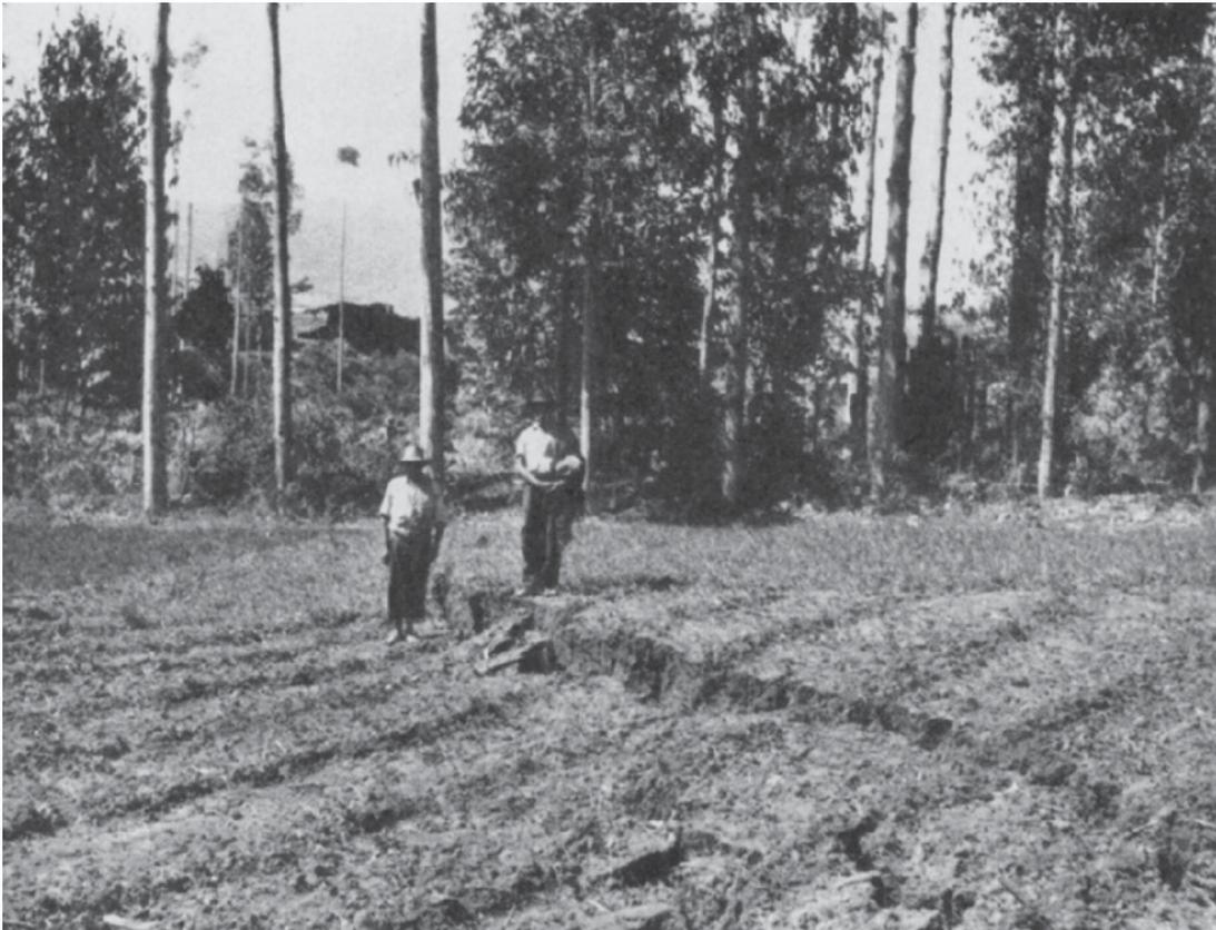
**Fotografía 6.4** Agrietamientos del terreno, sobre depósitos lacustres de la formación San Sebastián en el terremoto del 31 de marzo de 1950, la escarpa tiene una altura de 35 centímetros y está ubicada al sur de la cuenca del Cusco y al suroeste del distrito de San Sebastián. (Ericksen *et al.*, 1954).
