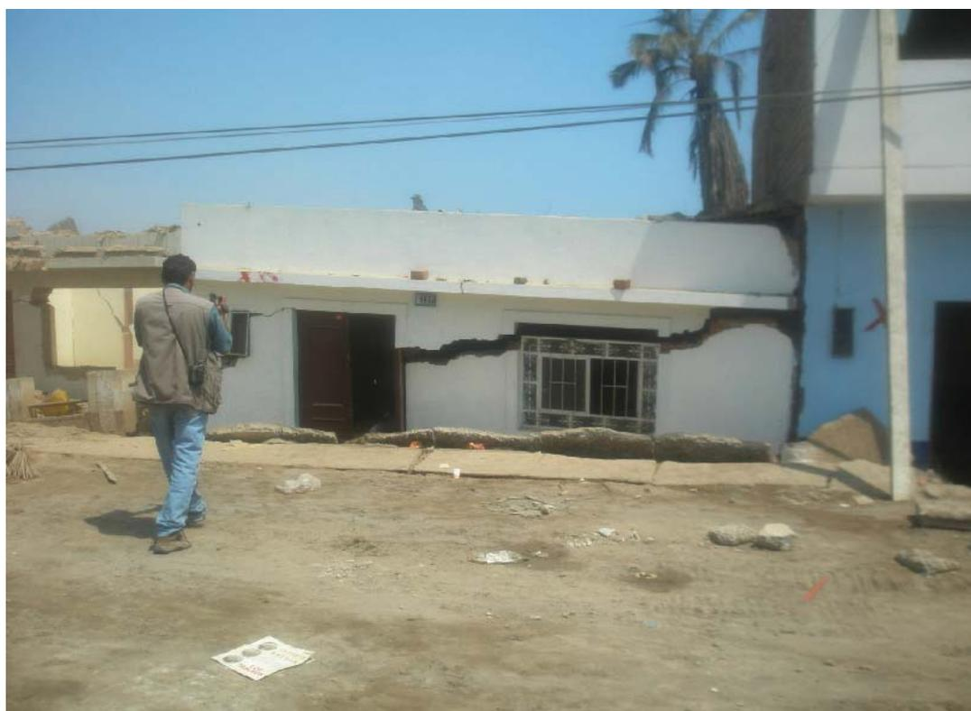
**Fotografía 6.9** Asentamiento de viviendas por procesos de licuación de suelos, provocando los colapsos en las viviendas, Pisco 2007.
