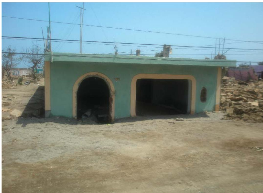
**Fotografía 6.8** Se observa el hundimiento de esta vivienda, producto de procesos de licuefacción de los suelos. Sector Tambo de Mora.
