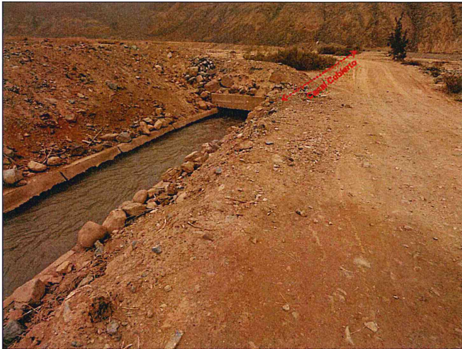
Foto 10. Se muestra el canal cubierto y sin cobertura.
