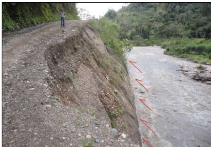
Foto 21.- Carretera afirmada Llochegua – Los Ángeles, sector de Tacora.
