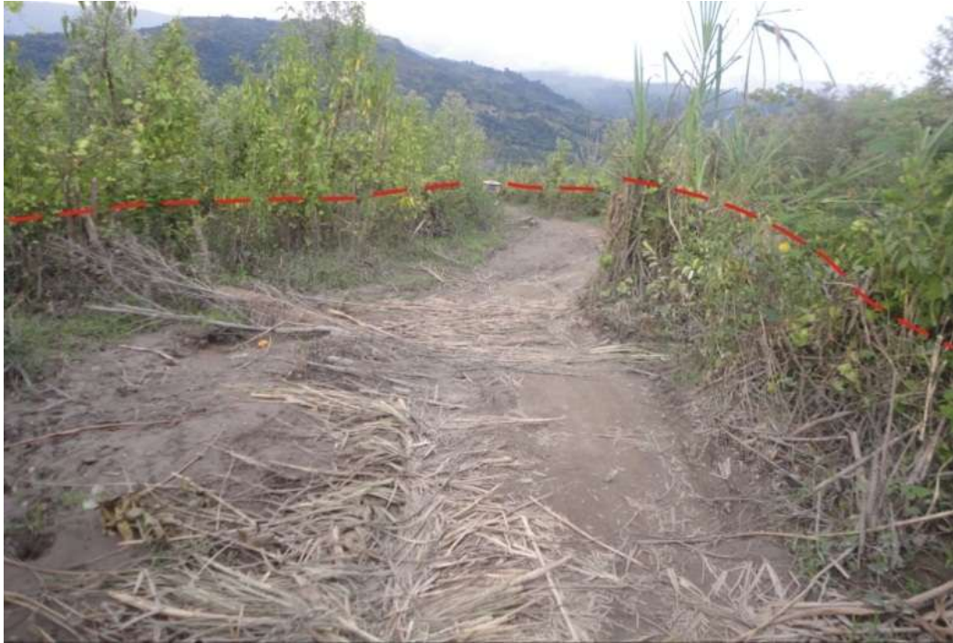
Foto 33. Se muestra con líneas rojas, el nivel alcanzado por las aguas del río Apurímac.
