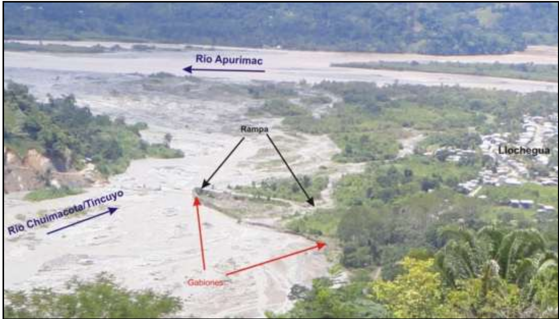
Foto 23 y 24.- Se muestra las defensas ribereñas y rampa de acceso al antiguo puente Tincuyo.
