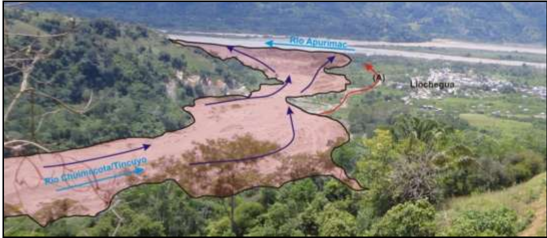
Foto 26.- Las flechas de color azul muestran el desplazamiento que ha tenido el flujo de detritos del 22 de noviembre del 2011. La de color Rojo (A) muestra el área por donde erosionó el flujo de detritos a la rampa de acceso.
