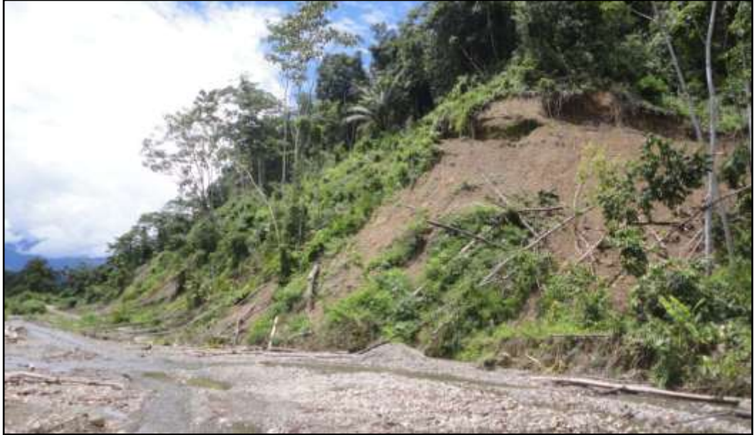
Foto 18.- El paso del flujo de detritos provoco erosión lateral en la ladera, generando derrumbes.
