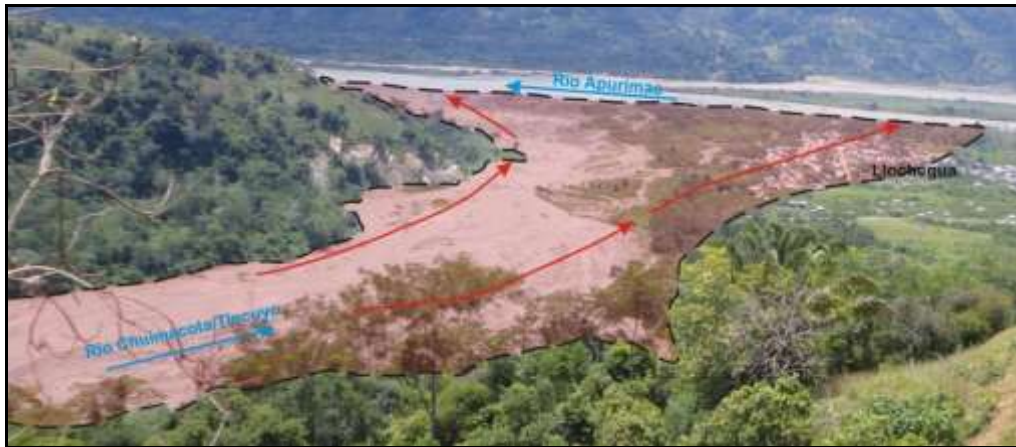
Foto 27.- Esquematización del desplazamiento del flujo de detritos del 22 de noviembre, en el caso de no haber estado las defensas ribereñas.
