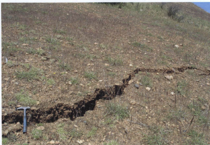
Foto N° 2: Grietas centimétricas orientadas al SO, (parte alta del deslizamiento), evidencian la inestabilidad del terreno.
