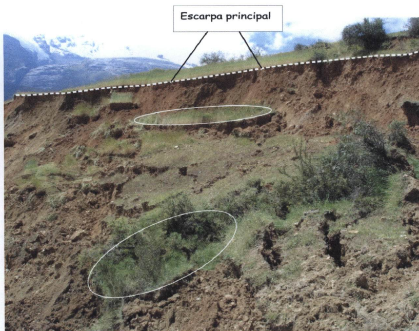
Foto N° 1.- Escarpa principal del deslizamiento, los círculos muestran como los terrenos de cultivo fueron seriamente comprometidos.
