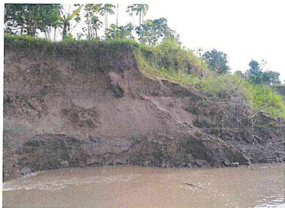
DESLIZAMIENTOS A CAUSA DE LA EROSION
