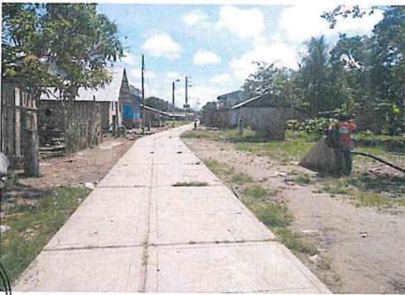
VIVIENDAS EN RIESGO POR INUNDACIONES
